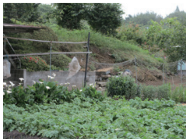
⑤民家敷地内を北西から南東方向に延びる土手状遺構
