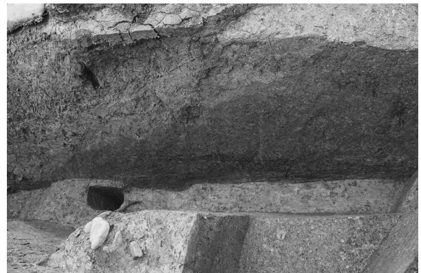
築地塀断面 (南から)
