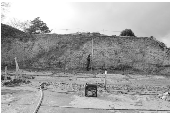
東側土塁工事立会（東から）
