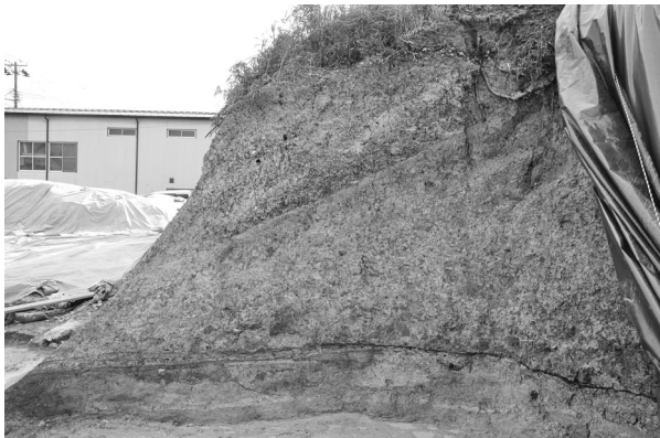
東側土塁断面63-64（北から）
