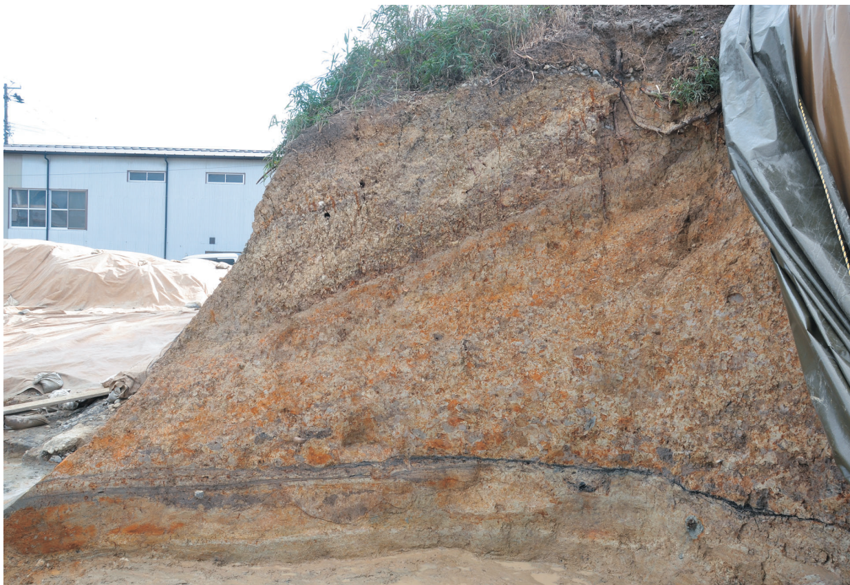
東側土塁断面（北から）
