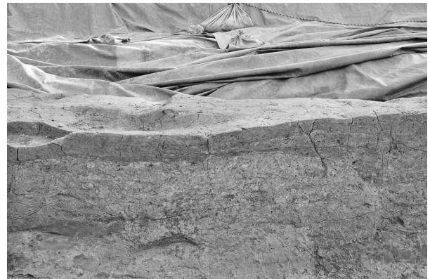
築地塀断面51-52②（北から）
