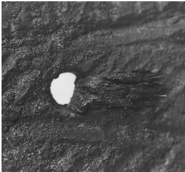
11補修孔部分拡大
