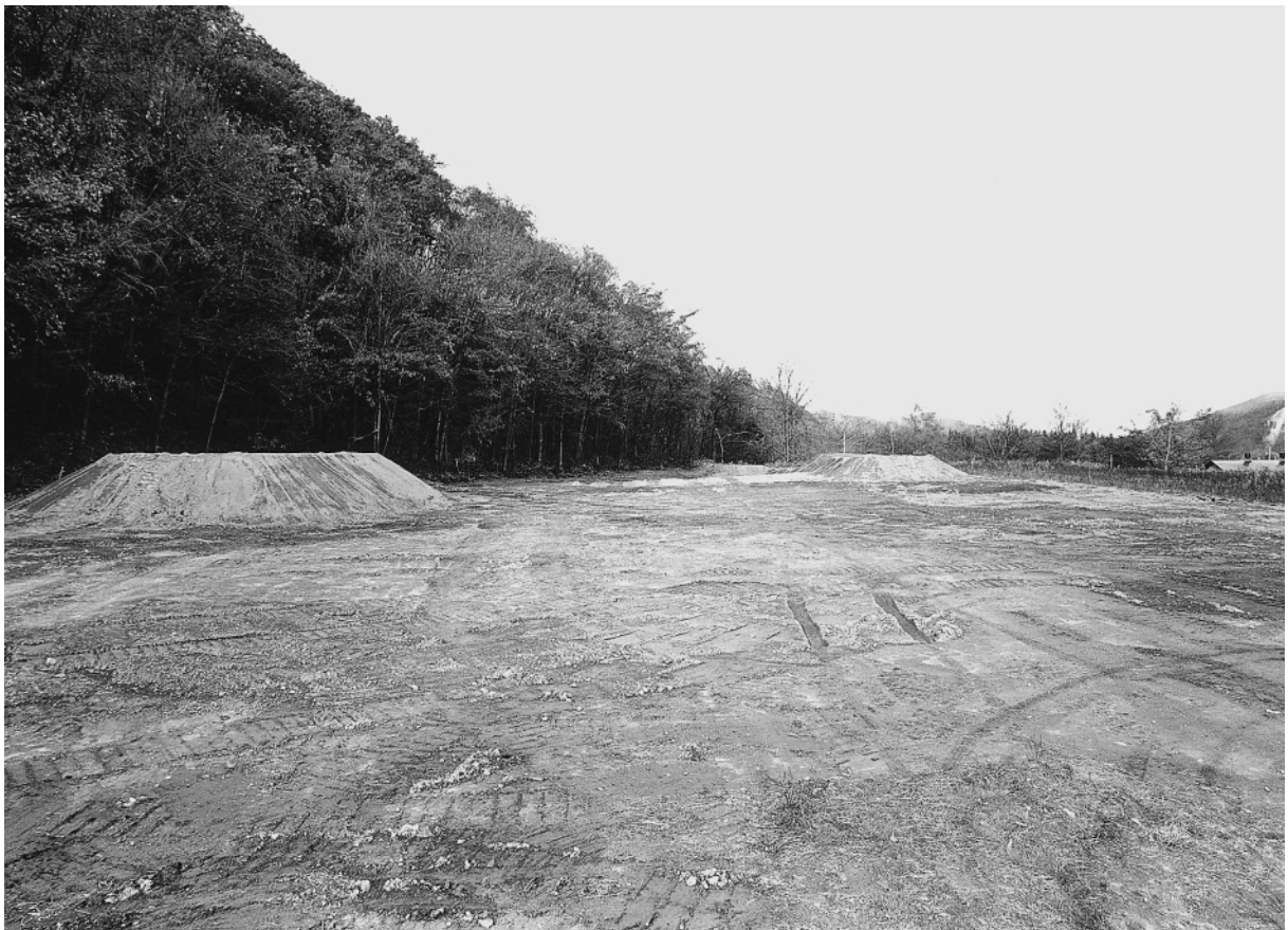
2 調査終了（南西から）
