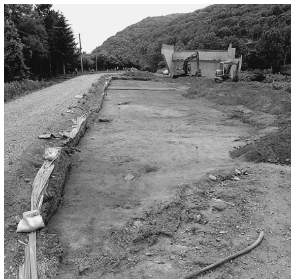
5 調査終了(北東から)
