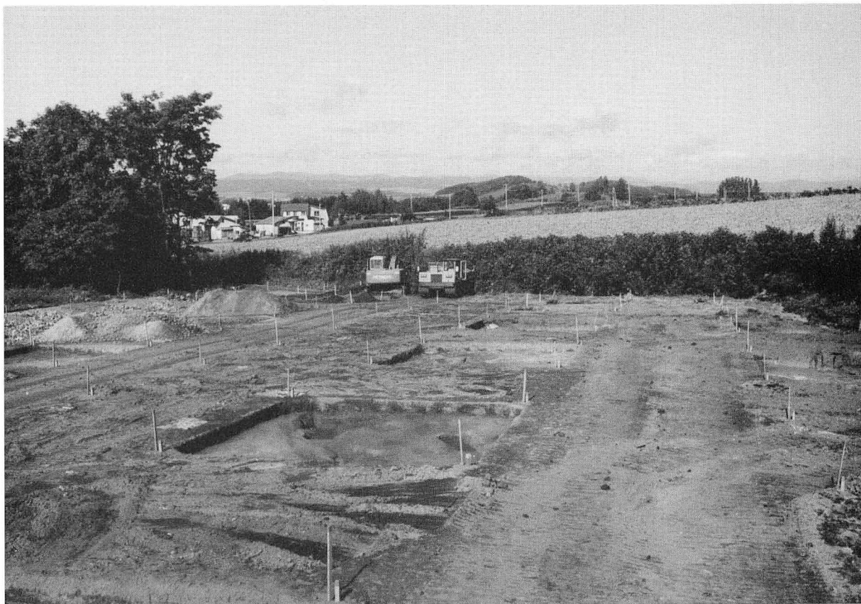
2 重機掘削状況（北東から）
