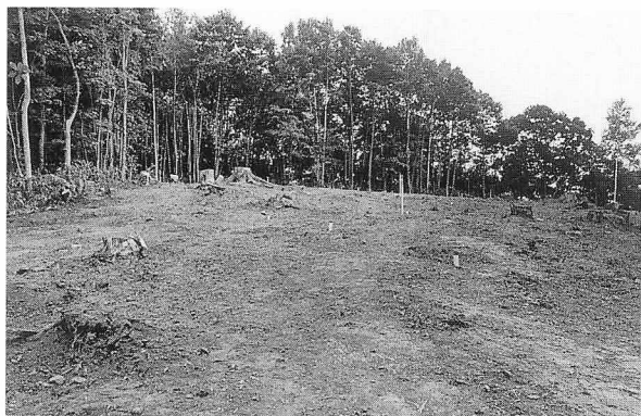
4. 調査前状況 (北西部)
