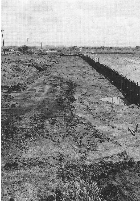
平成 8 年度調査区 (④区西側) W→E
