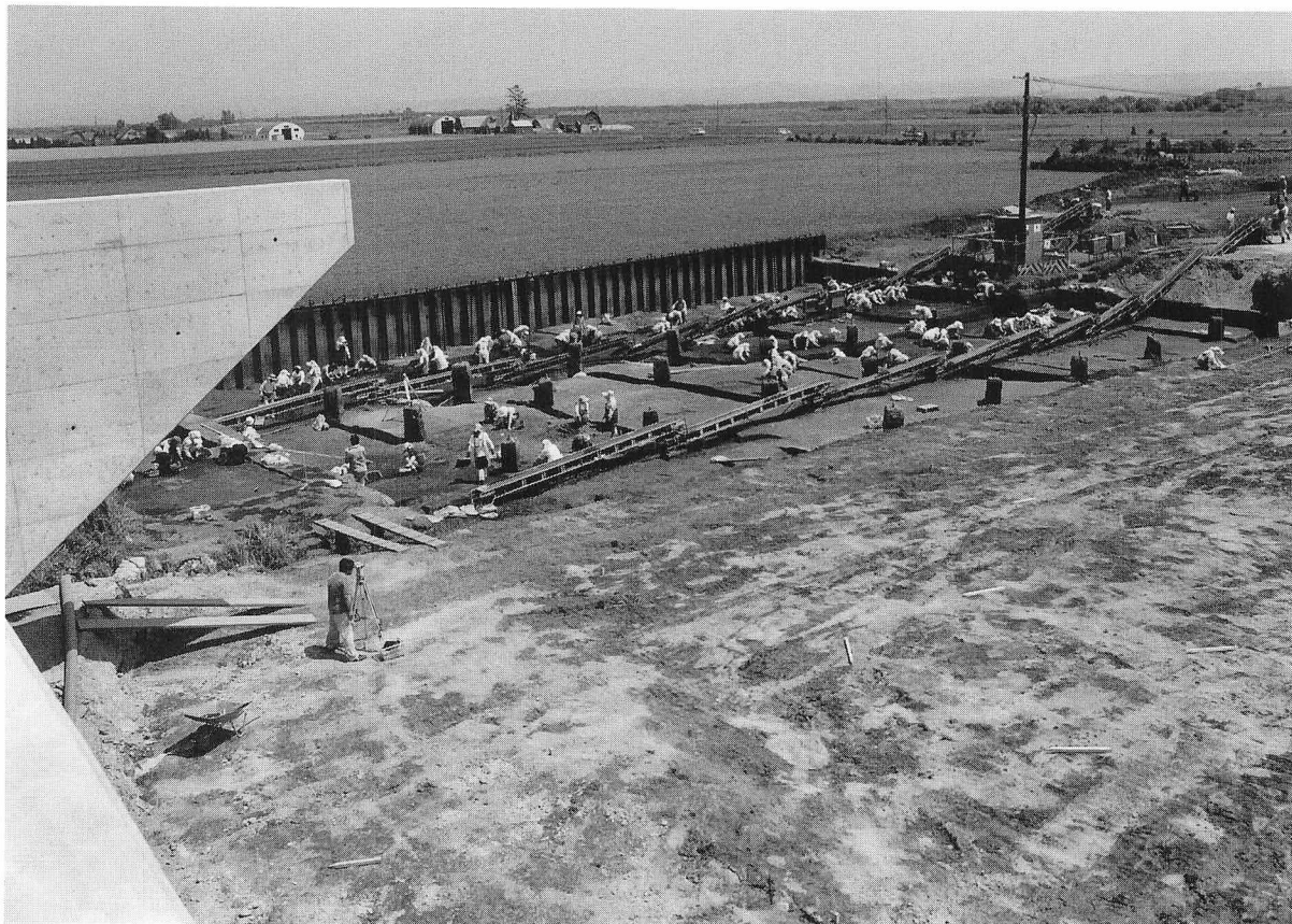
平成9年度調査区(②区北東側) SW→NE
