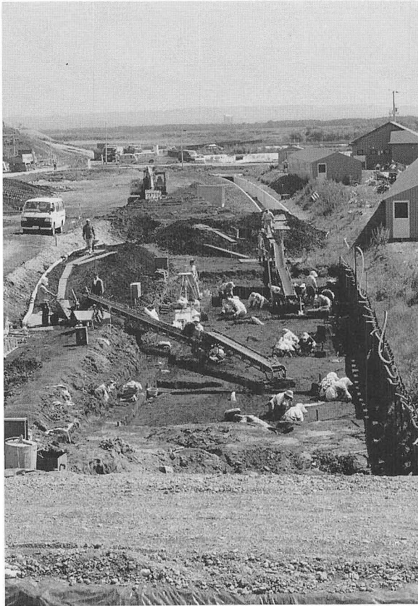
平成8年度調査区(④区東側) W→E
