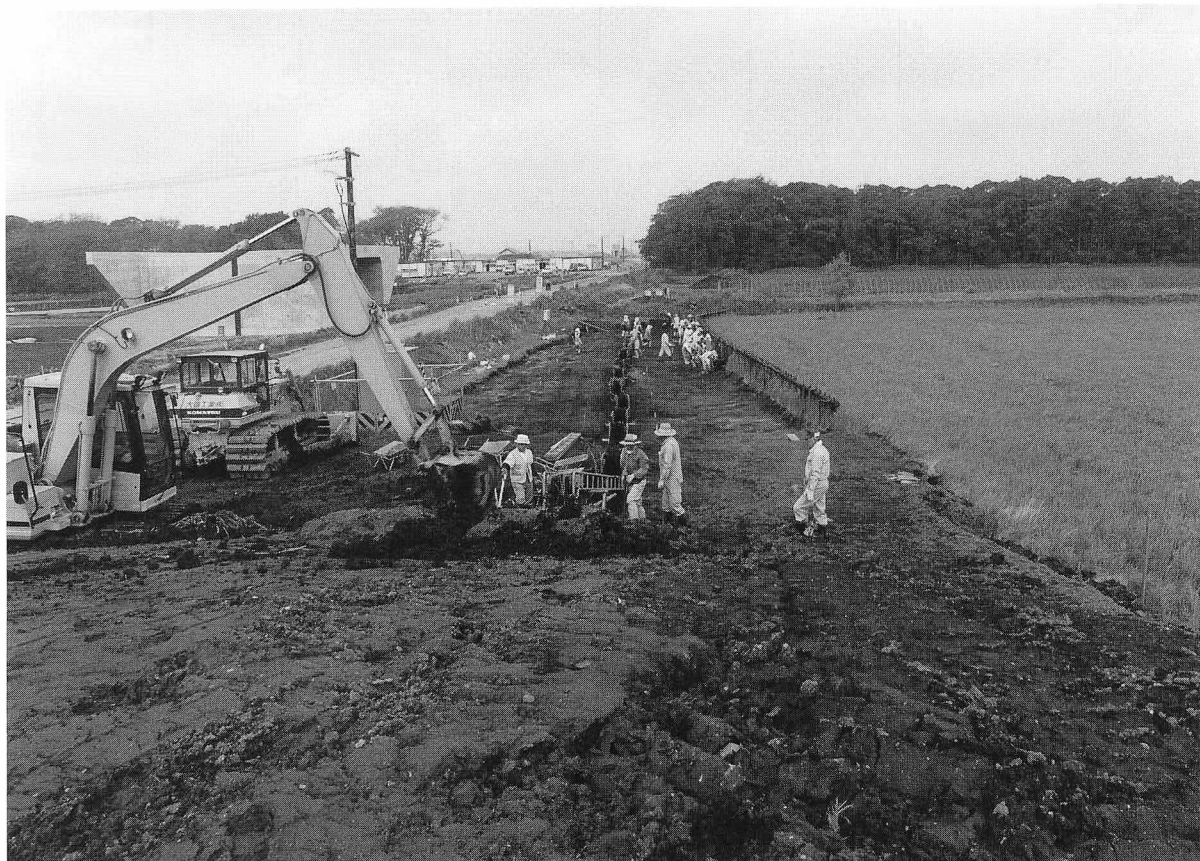
平成9年度調査区(②区北東側) E→W
