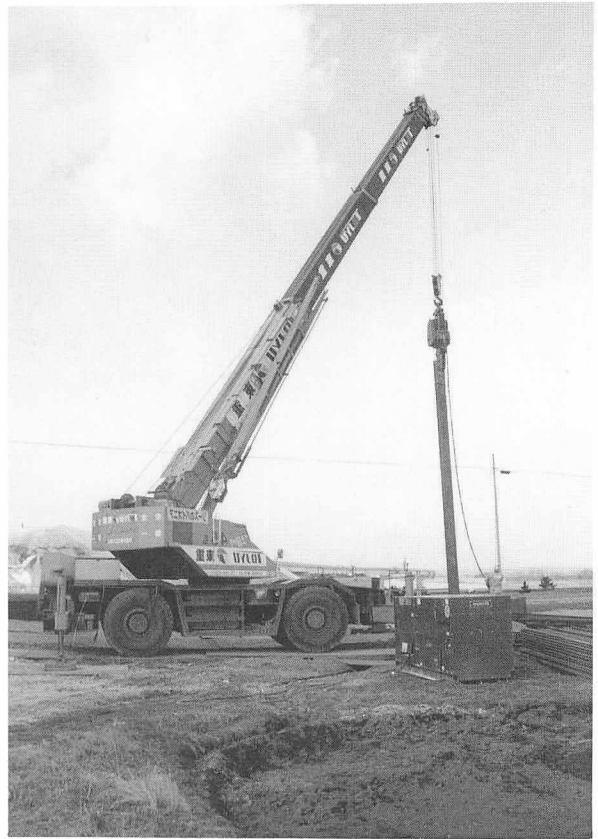
鋼矢板設置状況 W→E
