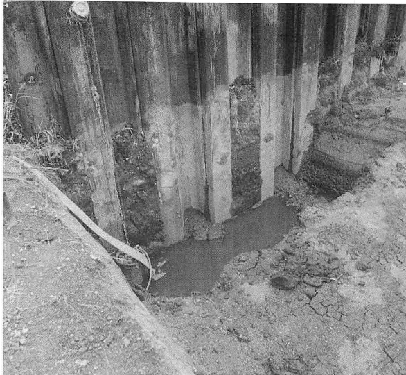
カマ場設置状況 NW→SE
