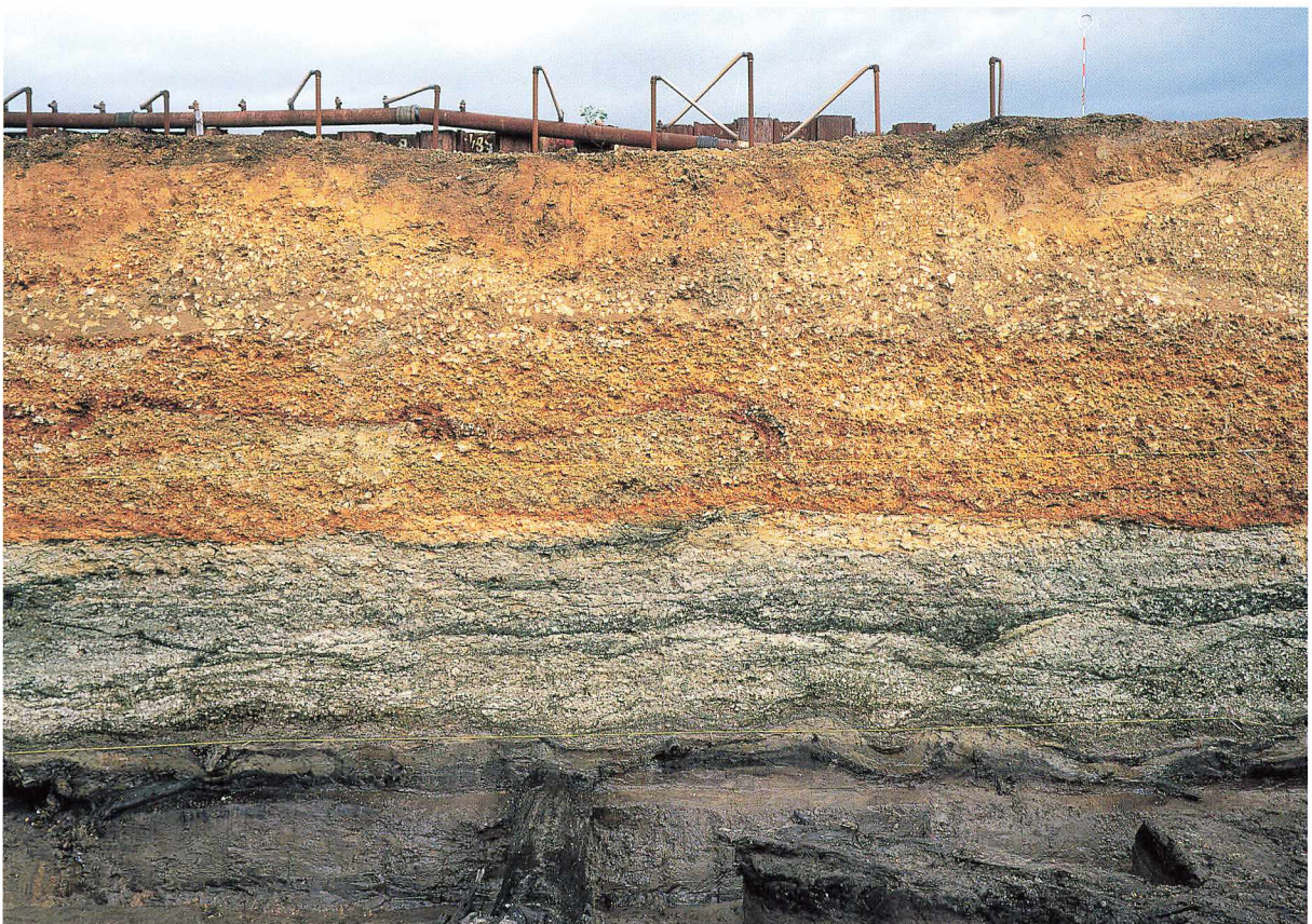
台地部深掘土層断面 S→N
