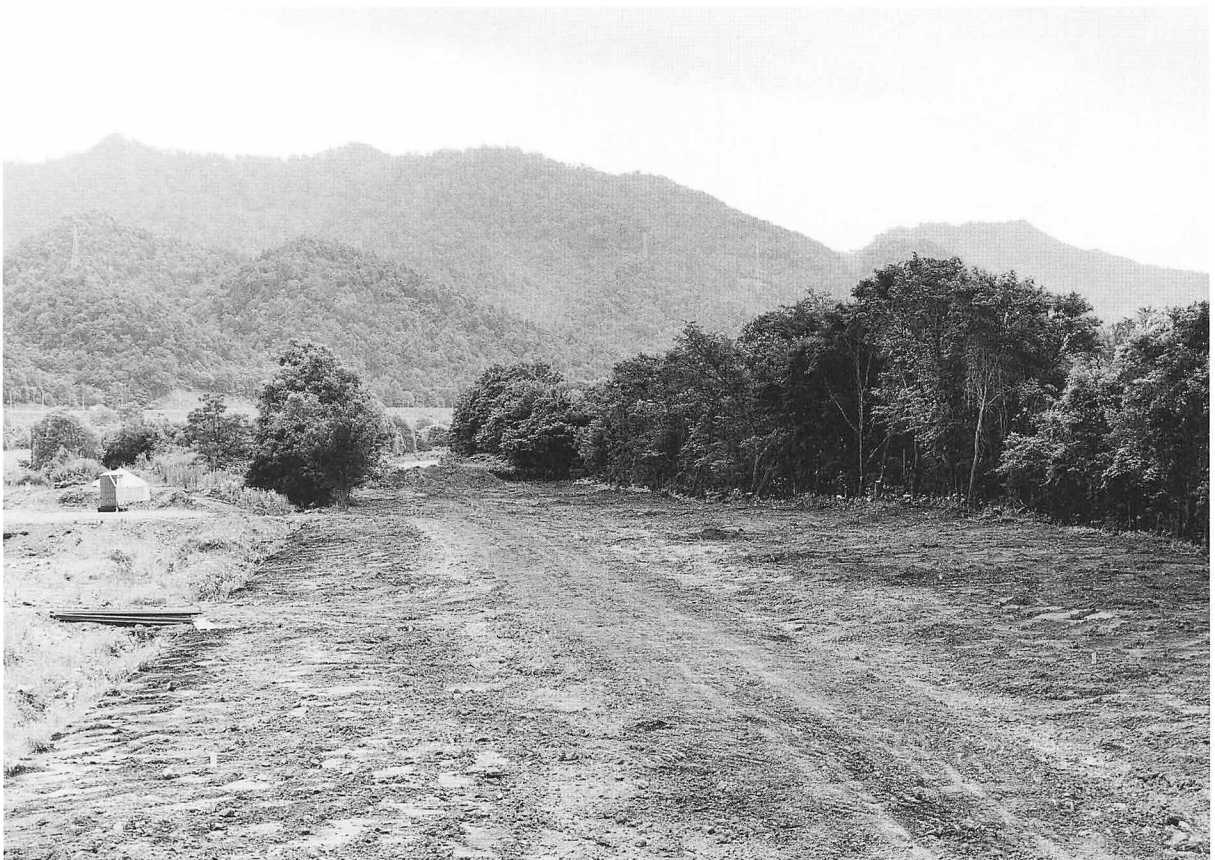
2. 調査開始前状況 (N W—S E)
