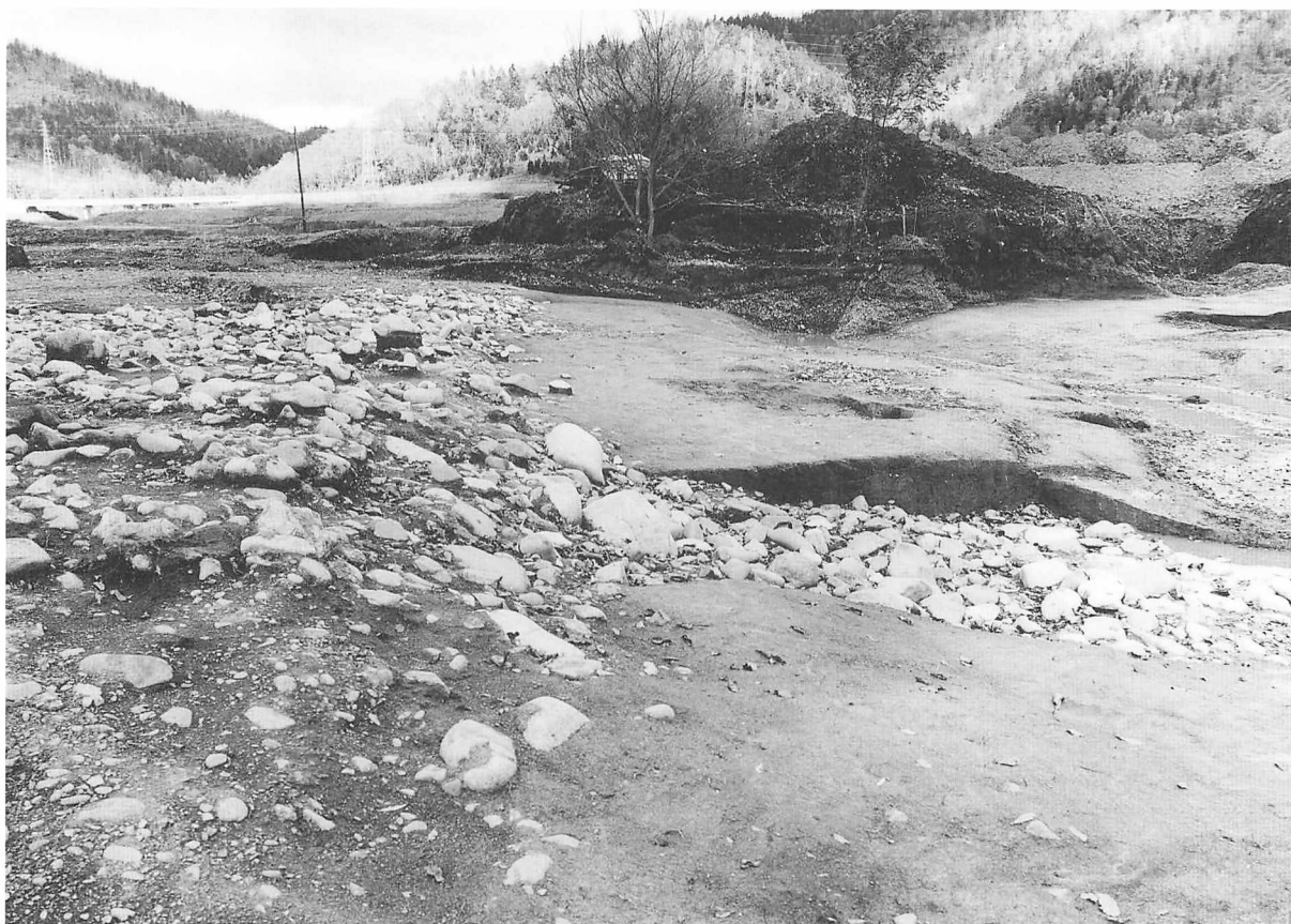
2. 沢地形の調査完了状況 (S-N)
