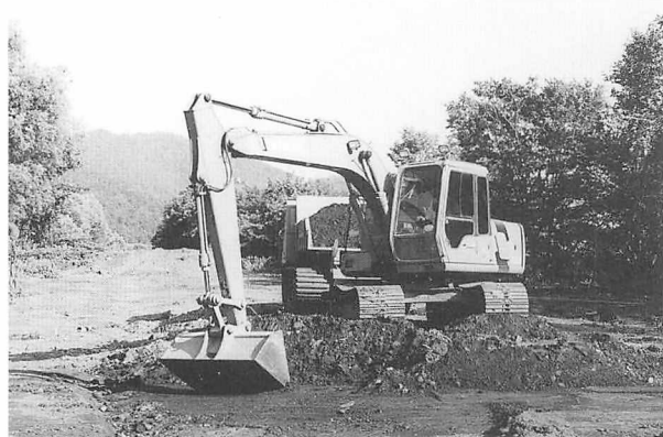
1. 重機による攪乱層除去
