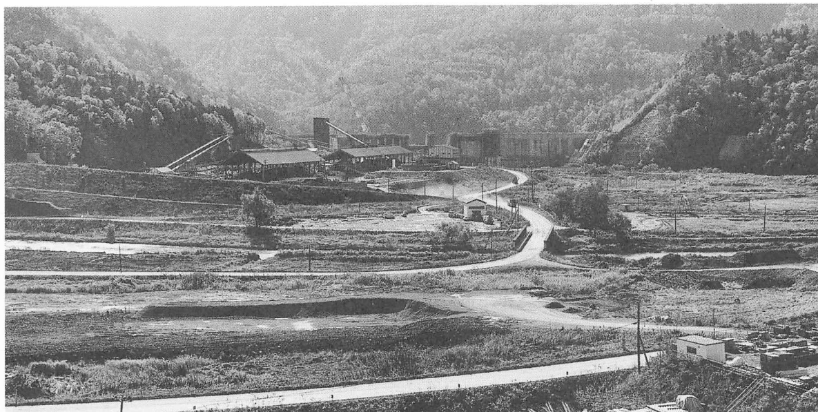
図版 I - 1 滝里ダム本体工事遠景
