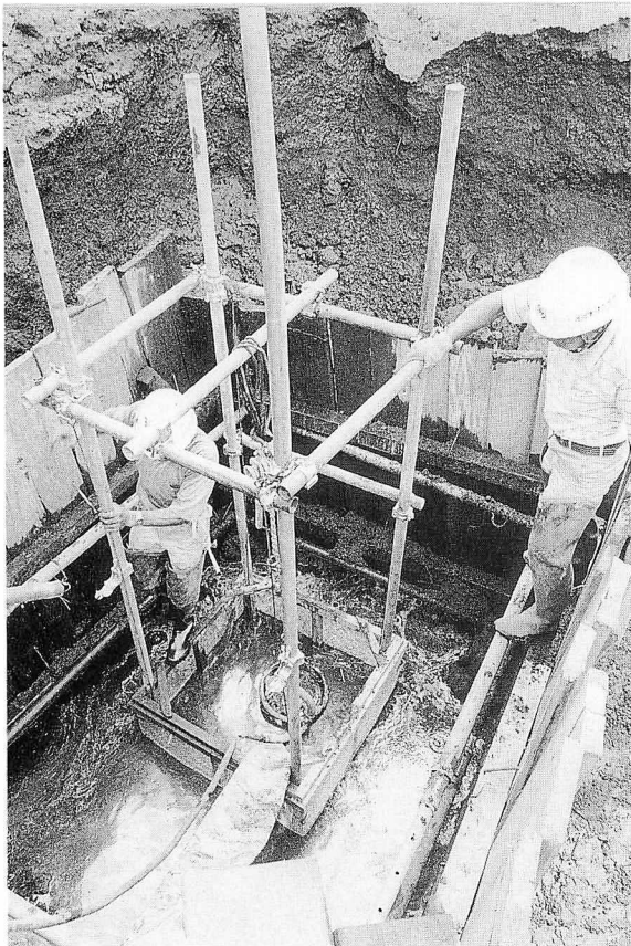
1 6インチポンプの釜場設置状況 (NW→SE)
