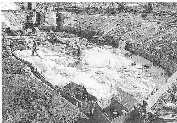
3 越年のためのシート貼り作業 (W→E)
