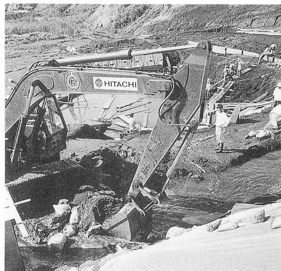
2 バックホウによる排水溝清掃 (E→W)
