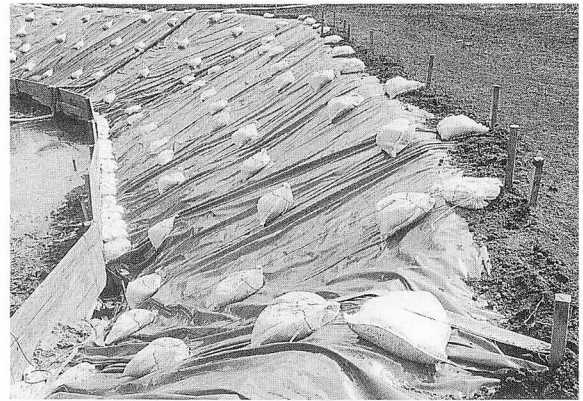
3 法面保護シート貼り状況 (W→E)
