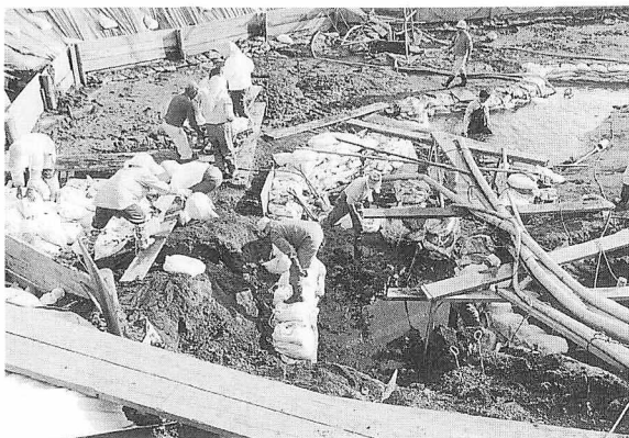
1 越年のための崩落防止作業 (N→S)
