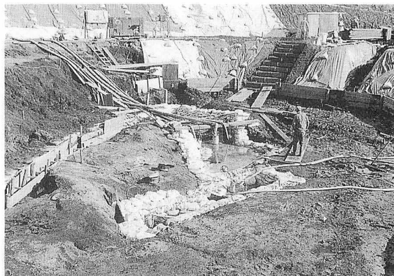
2 崩落防止作業終了 (W→E)
