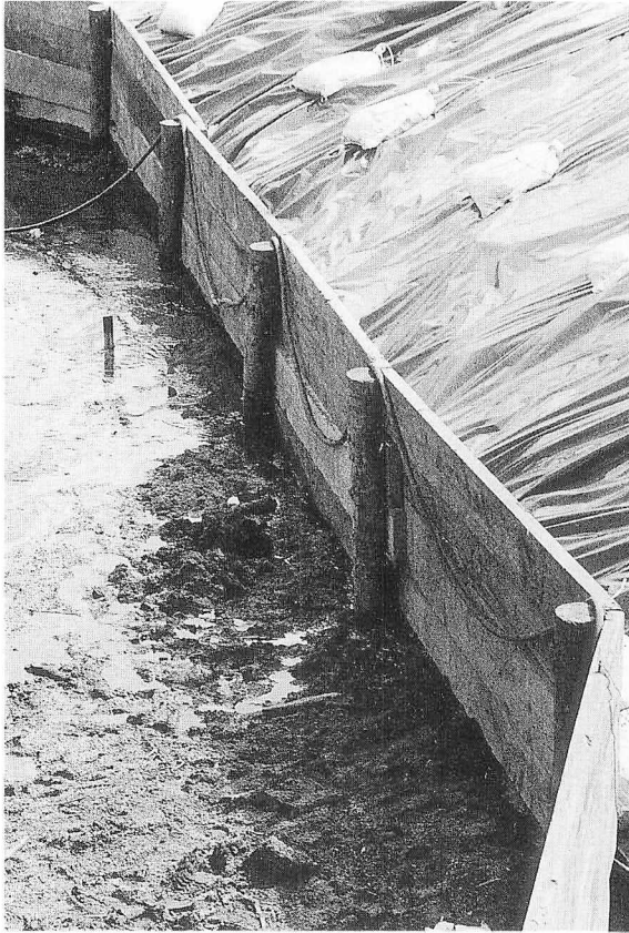
1 法面下部土留板設置状況 (W→E)
