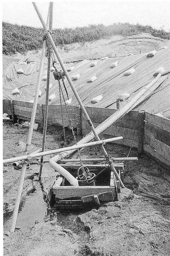
3 4インチポンプの釜場設置状況 (W→E)
