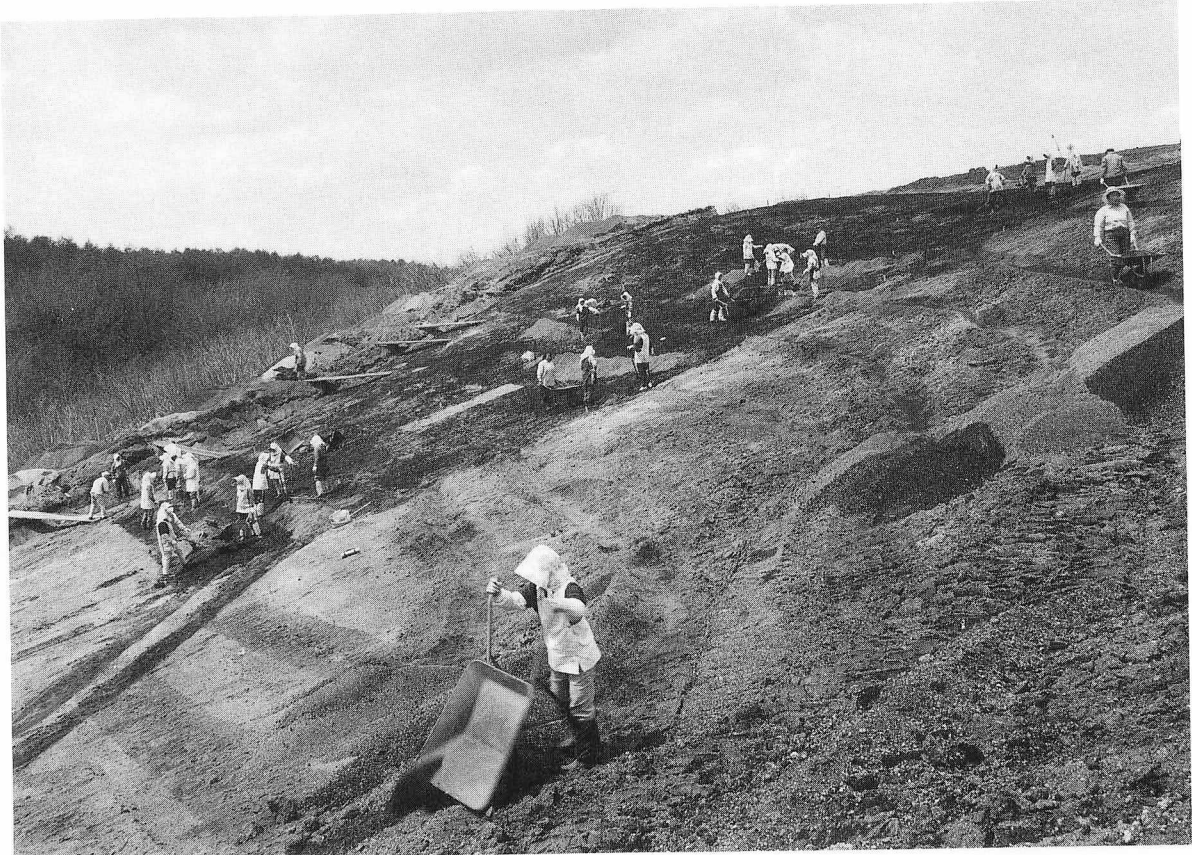
1 斜面作業風景 SE→
