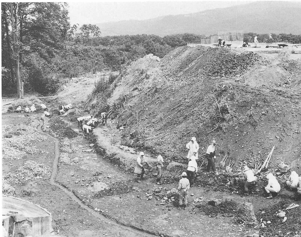
沢地区の作業状況
