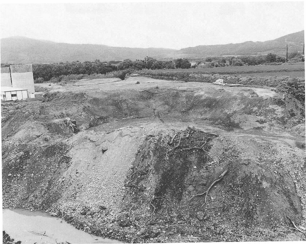
東地区の作業終了状況
