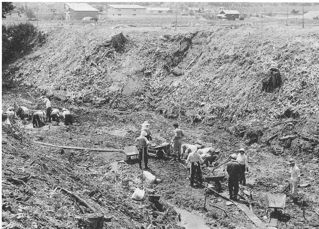
沢地区の作業状況
