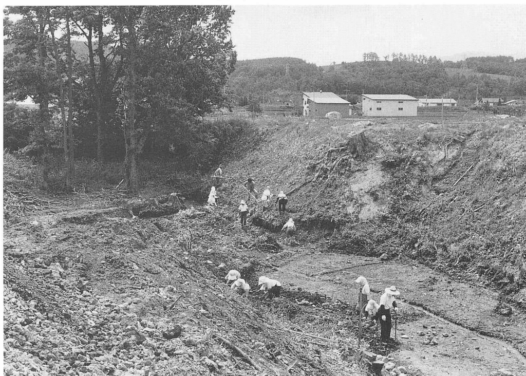
沢地区の作業状況
