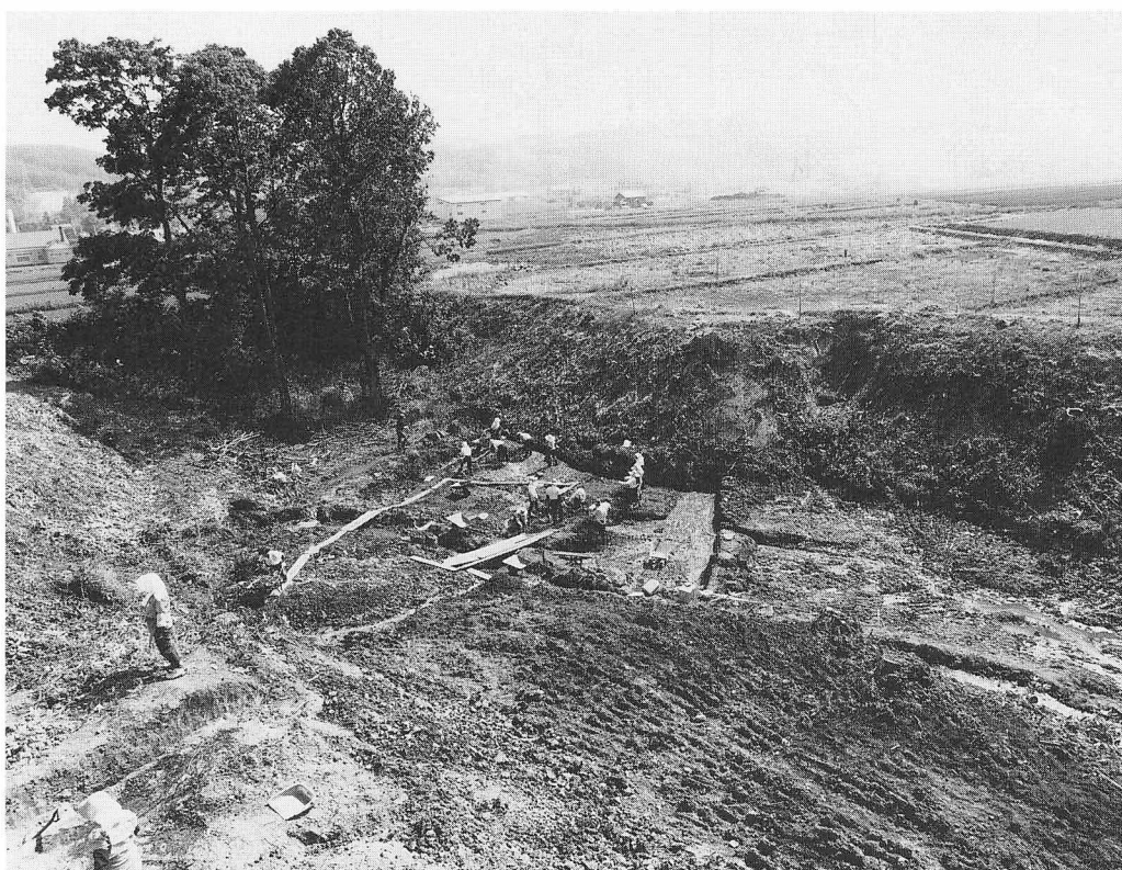
沢地区の作業状況
