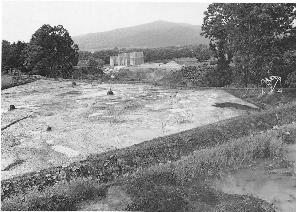
中地区の作業終了状況
