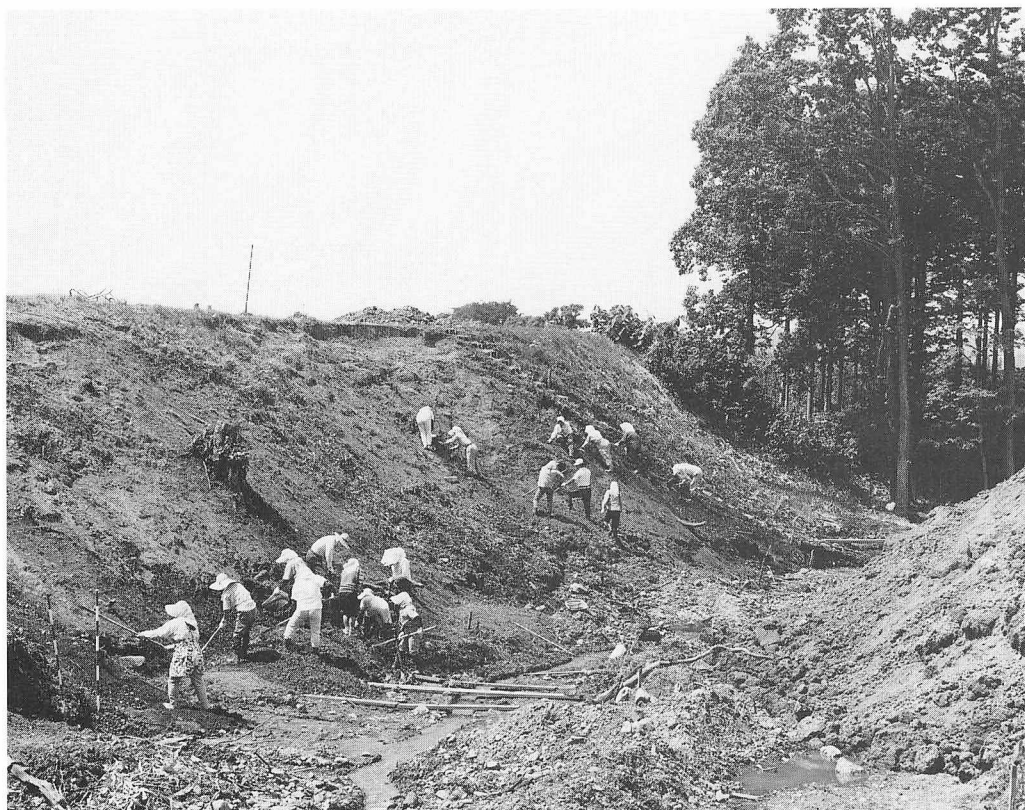
沢地区の作業状況
