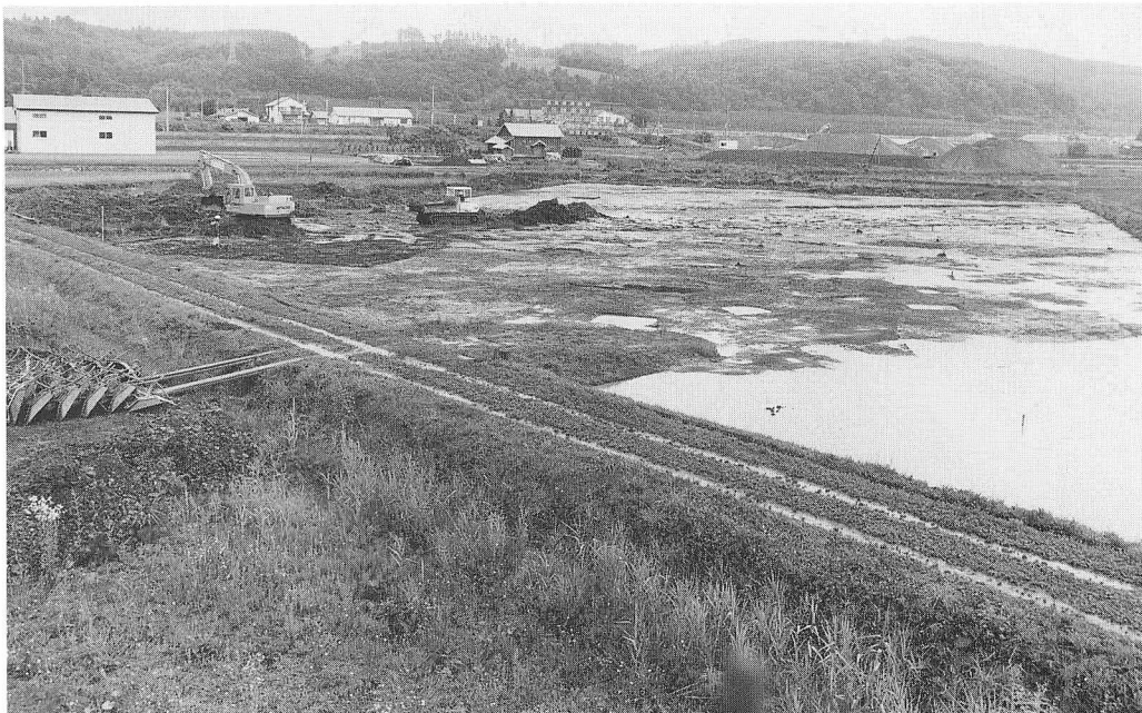
南地区の作業状況
