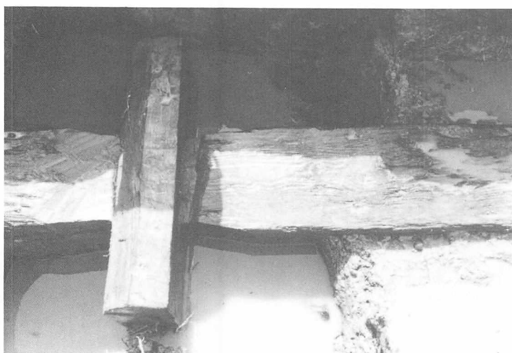
2、継手 r 東側から
