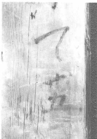
管 O - 北側西面
