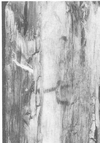
管H-南側西面
