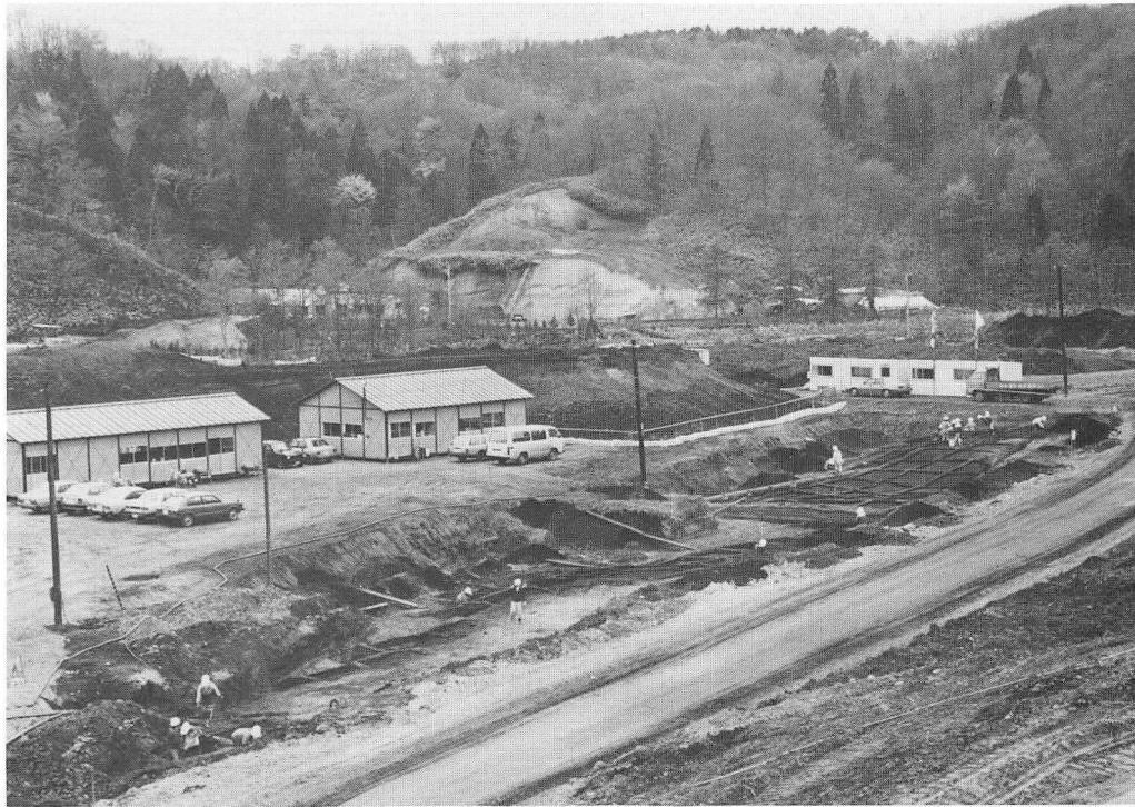
作業風景（黒色土除去 SE → NW）
