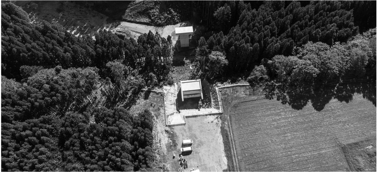
調査前状況（橋脚より左が北側地区・右が南側地区）
