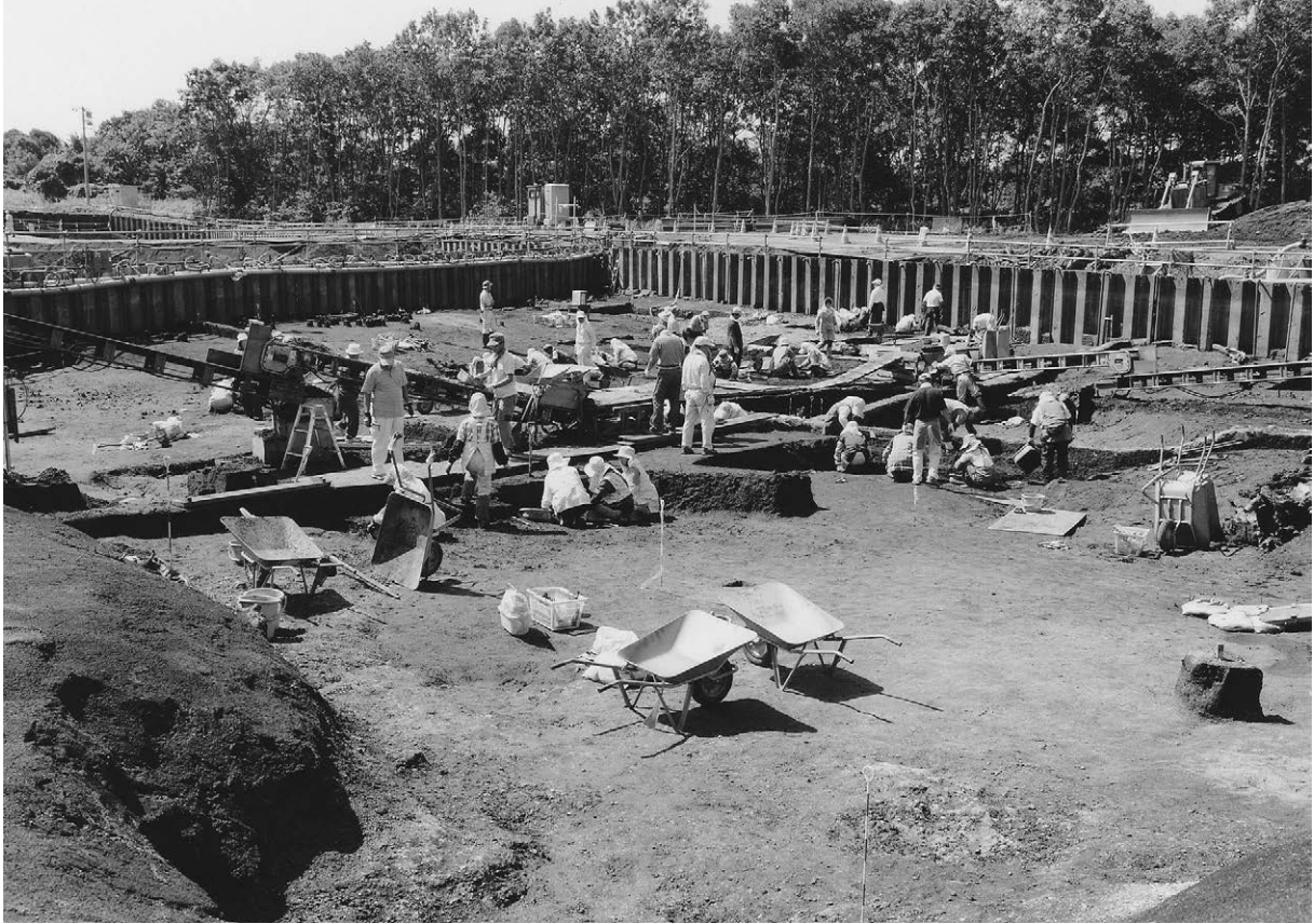
旧河道部調査状況
