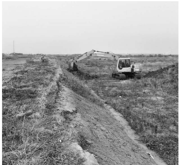
遺跡保護工事状況
