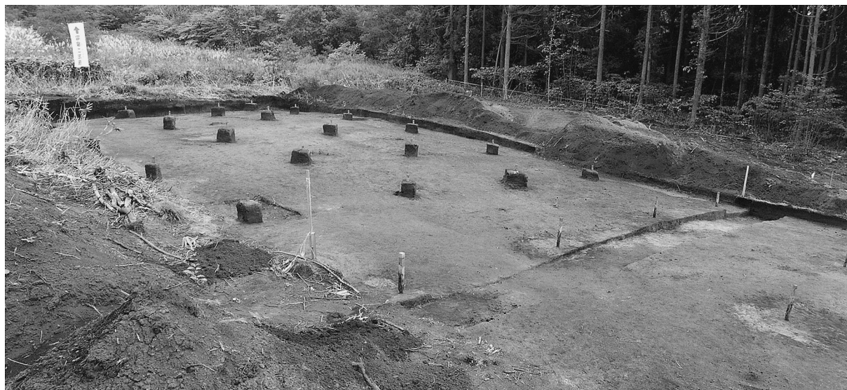
調査終了状況（発掘調査部分）
