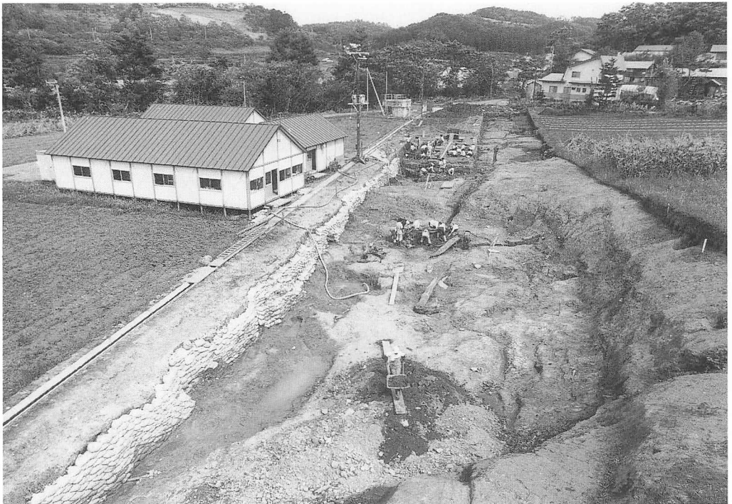
発掘調査風景（調査区西端より）
