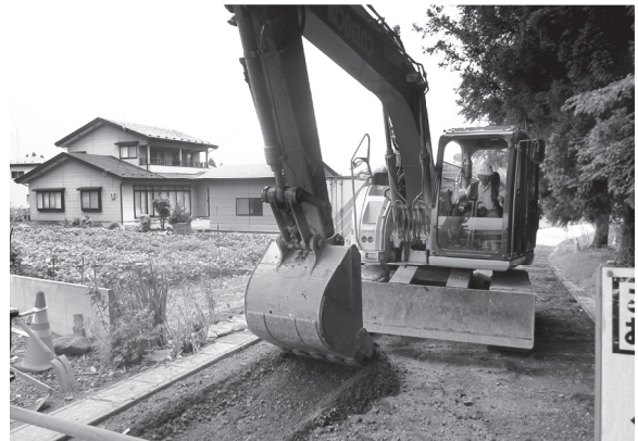
調査前 (西から)
