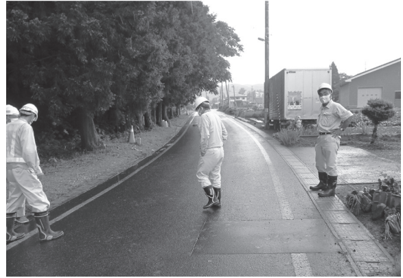
調査前現況 (東から)
