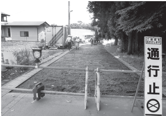
調査前 (西から)
