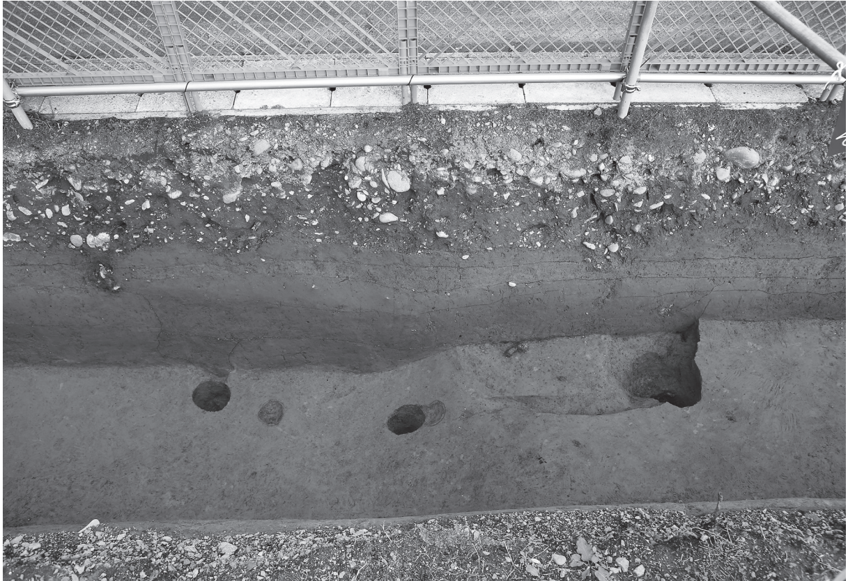
1号竪穴建物全景（西→）
