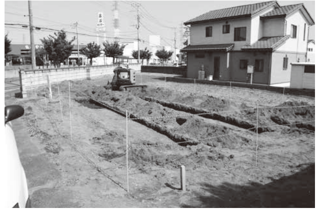
16 松原遺跡第 8 次調査区
