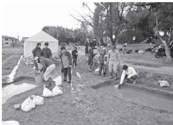
2 排水作業 (第11・12調査区)
