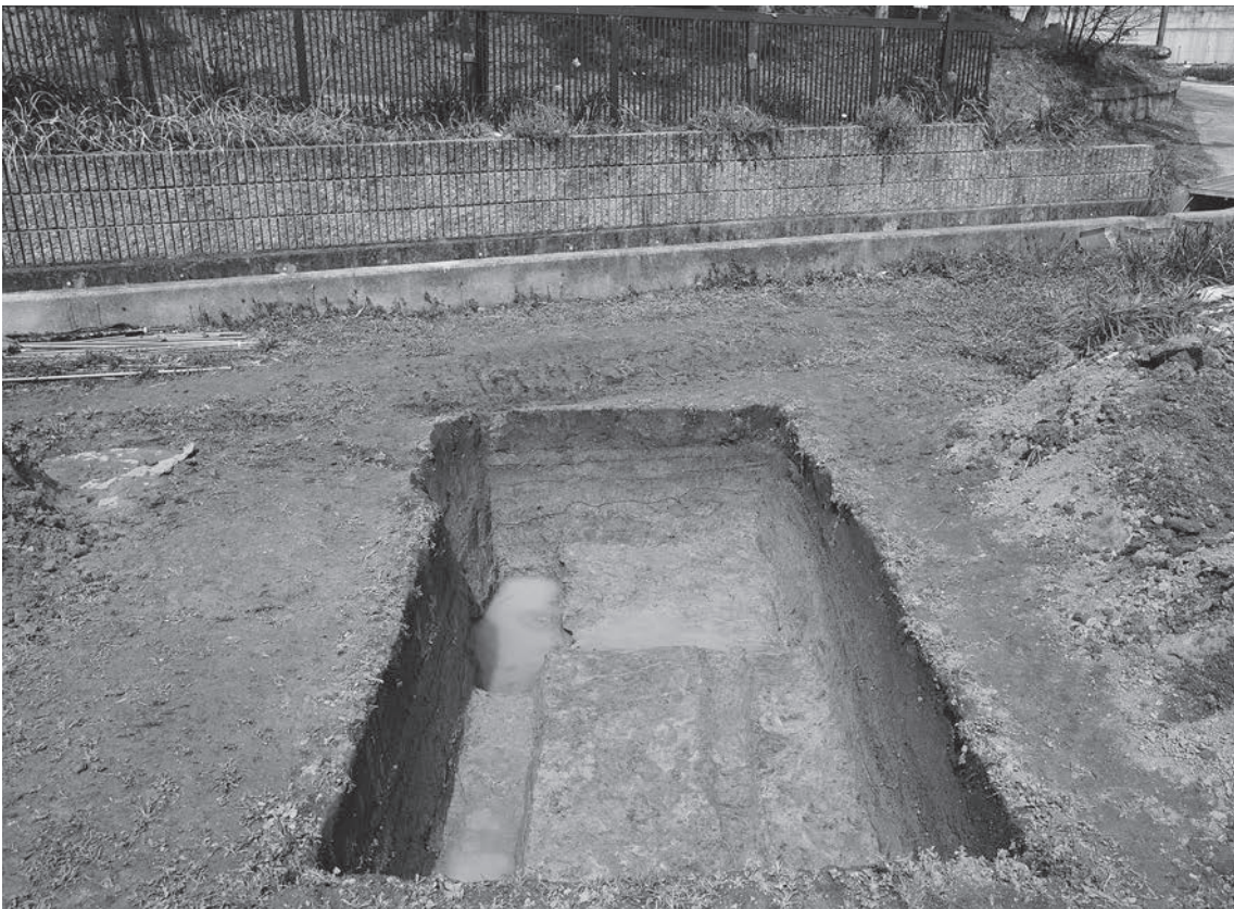
8 第7調査区完掘状況（南から）
