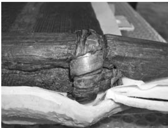
写真7 棒材結合緊縛状況
