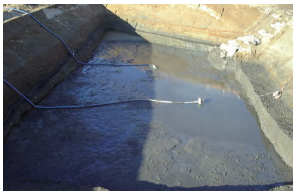
00A区 SX8001 完掘状況 (南より)
