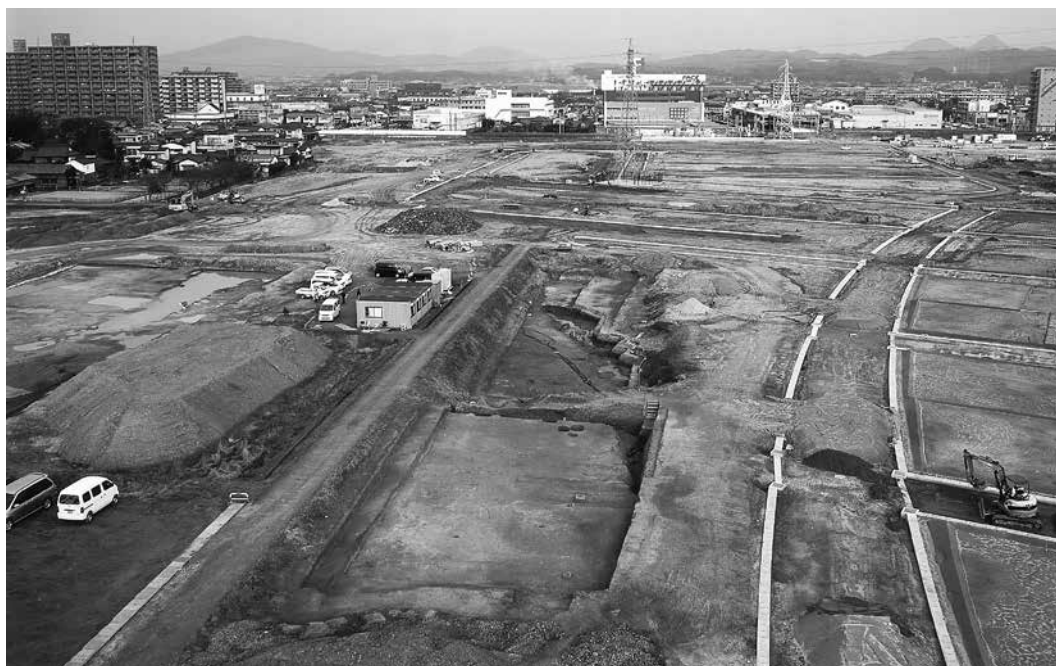
15-1 K-1・2地区 全景 (南東から)
