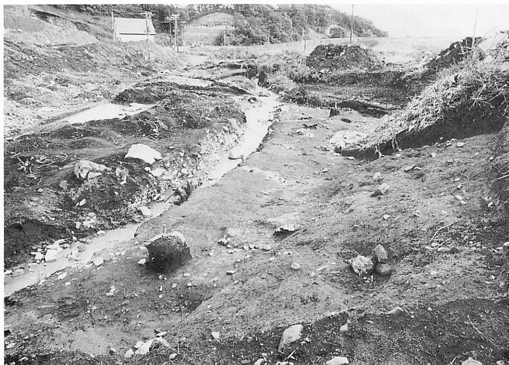
切り替え河道の西側の調査状況
