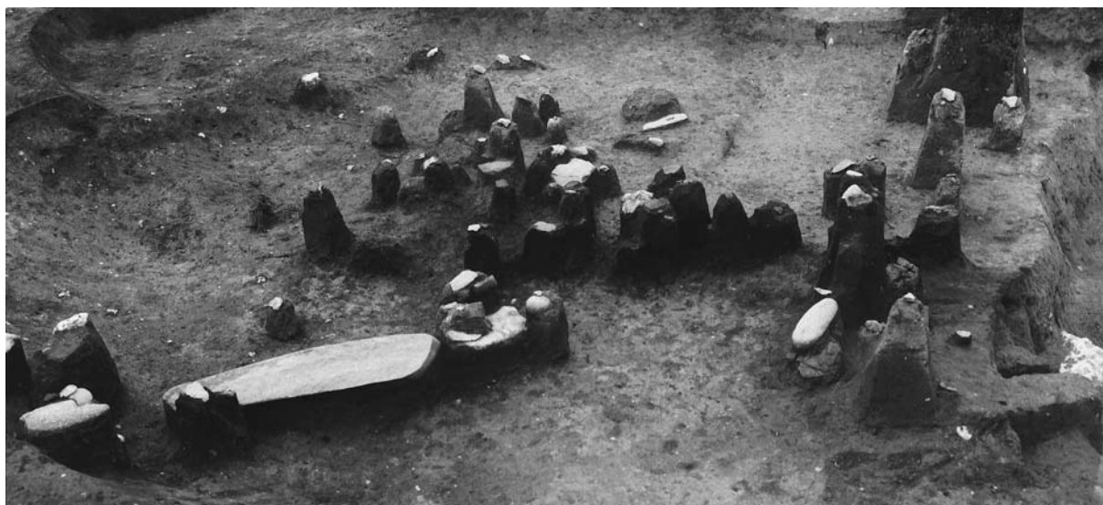
2 H-3 遺物出土状況 (南から)
