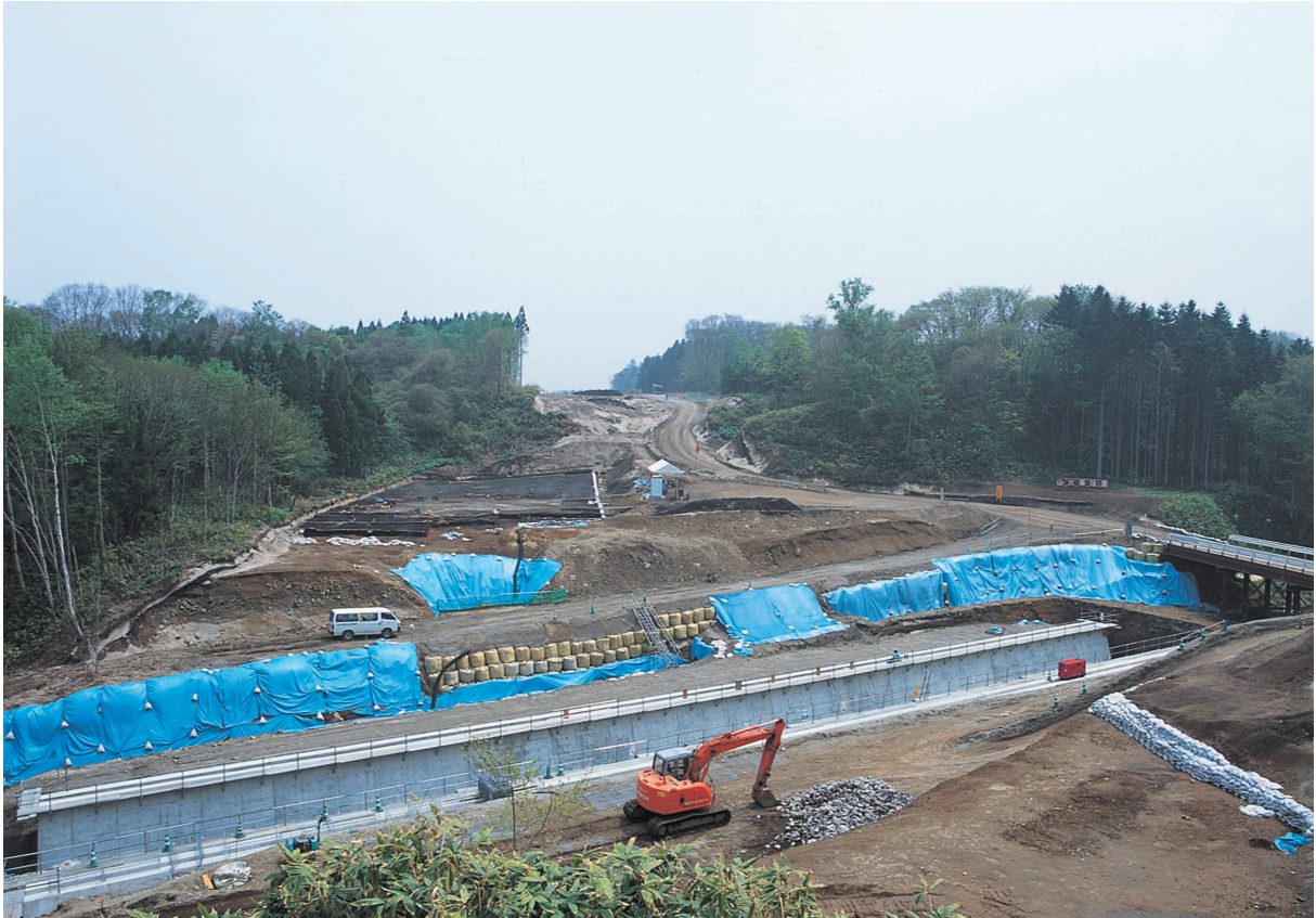
1 遺跡遠景（北西から）
