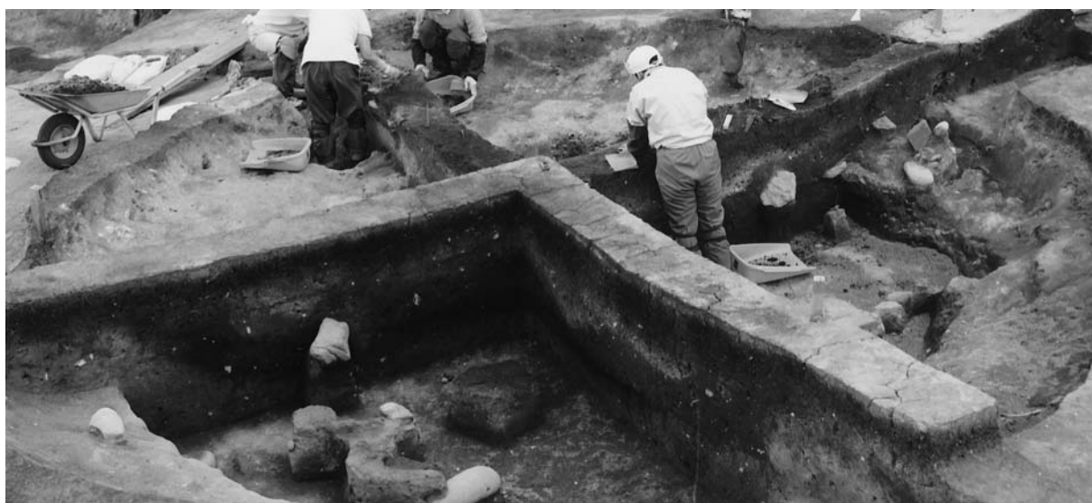
3 H-14土層断面及び調査状況（南から）
