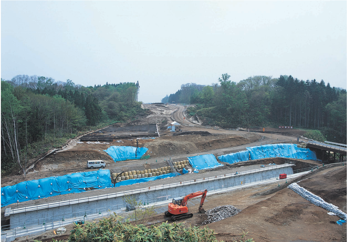
1 遺跡遠景（北西から）
