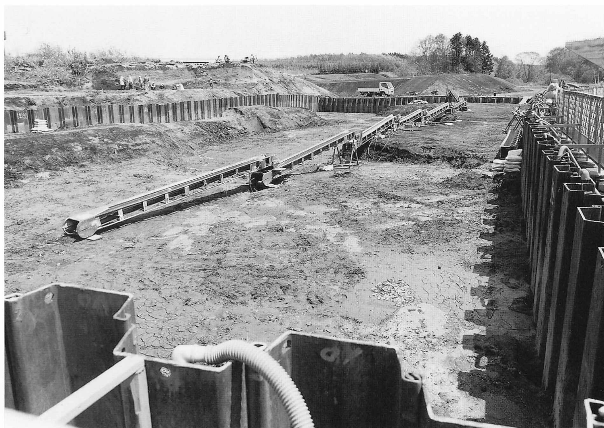
準備工事完了
