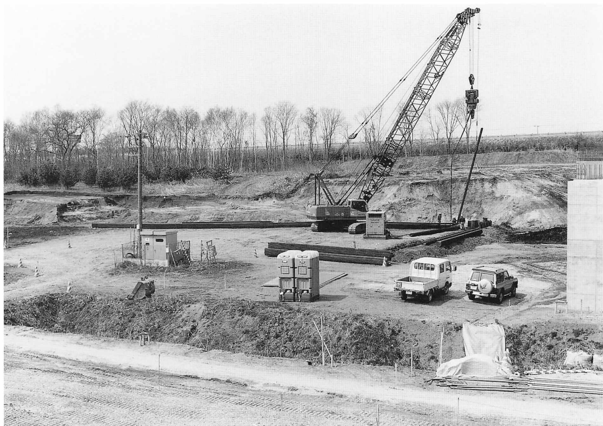
鋼矢板設置工事
