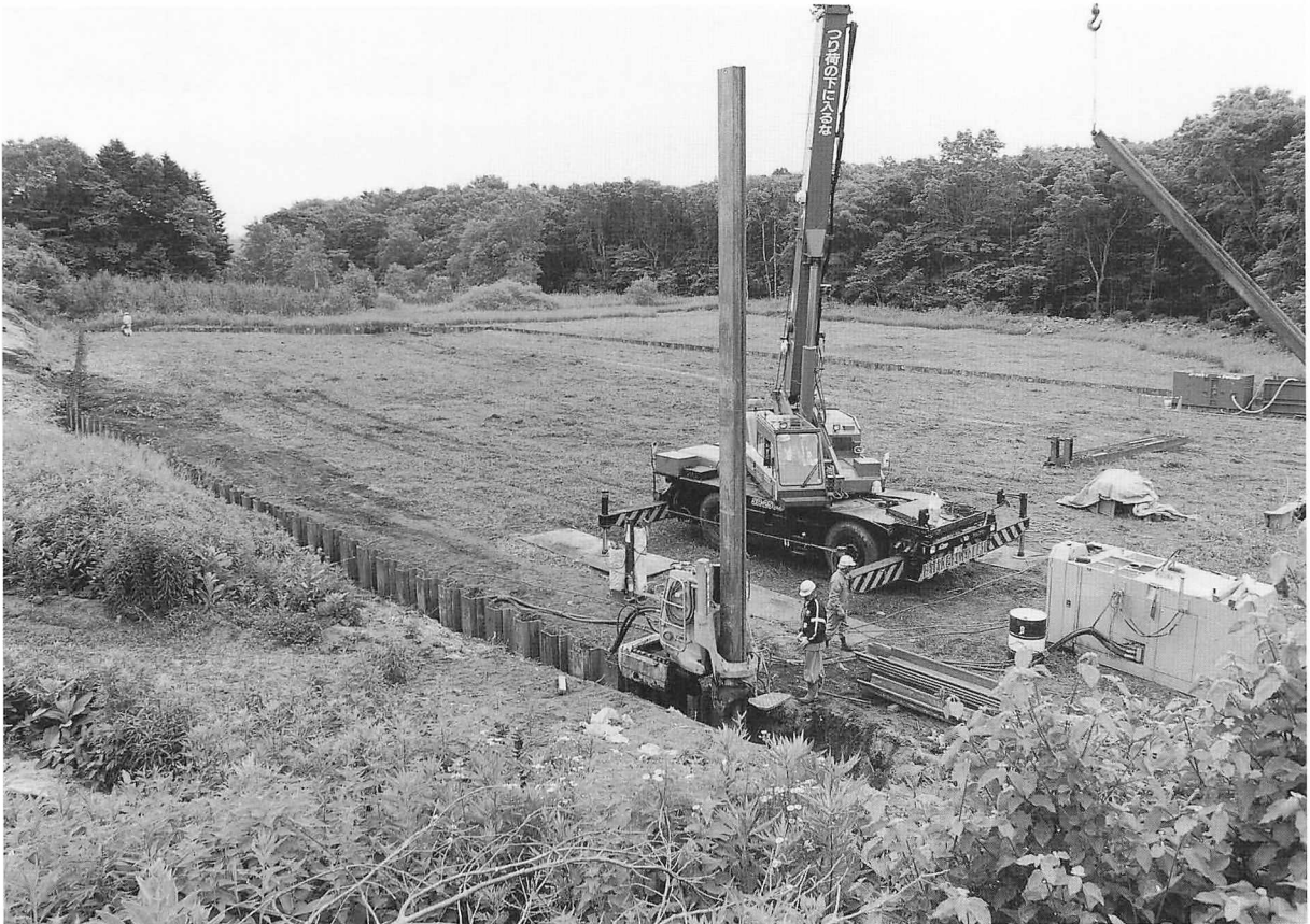
鋼矢板設置工事
