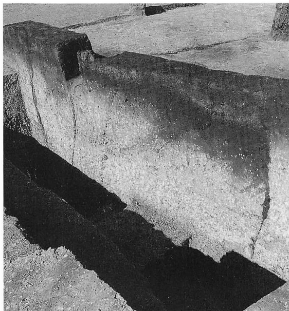
地割れ跡断面
