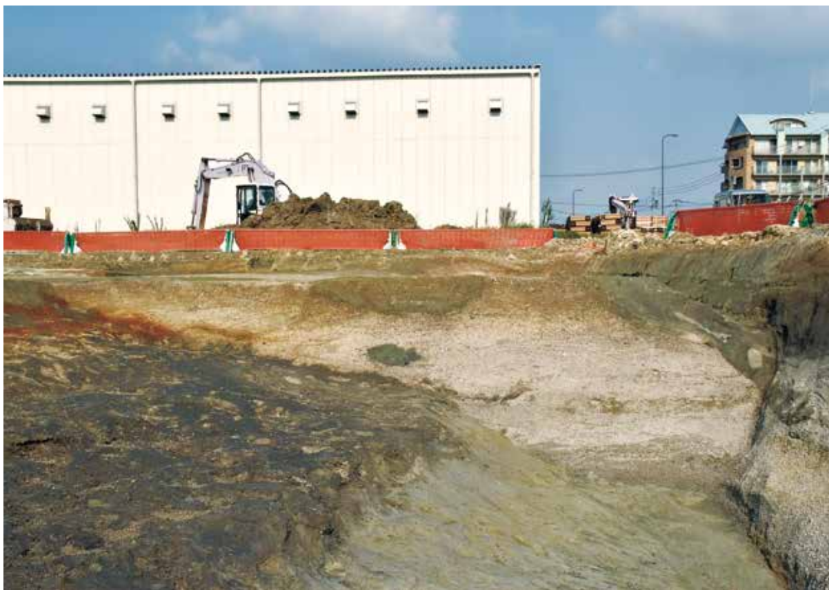
(2) SD01中央土層 (南から)
