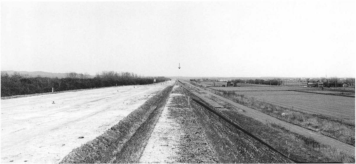
1 遺跡遠景(田浦地区・高速道路の工事中盛土より、北西から)
