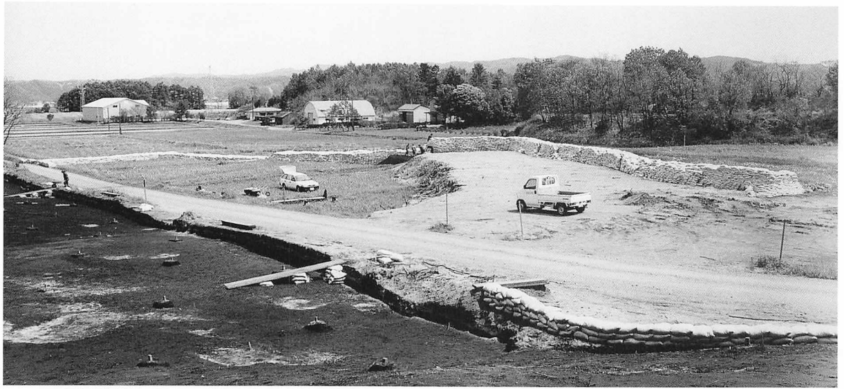
1 土嚢集積状況(南から)
