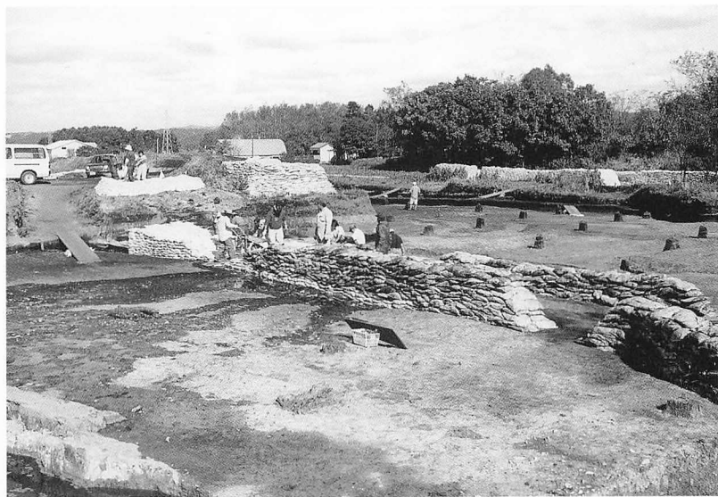
4 作業風景(簡易水道管保護、南東から)
