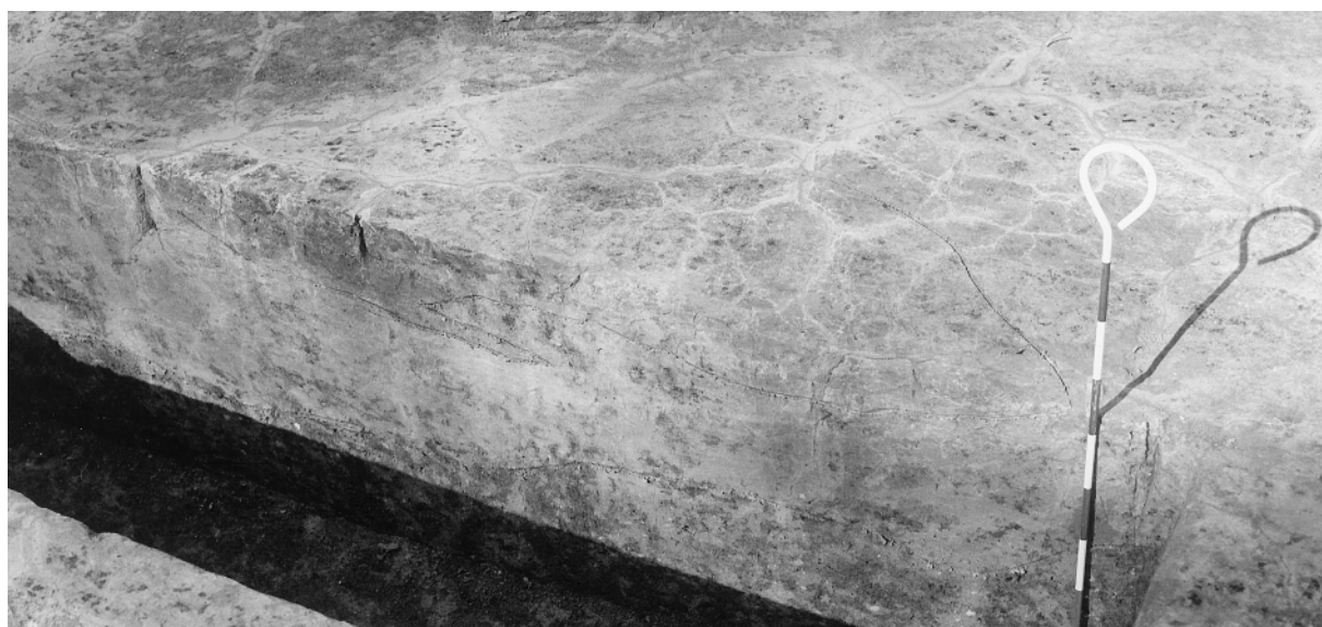
2 F 1 (3) 断面 (042区、東から)
