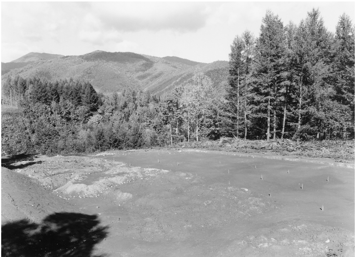
2 西側調査終了(南東から)
