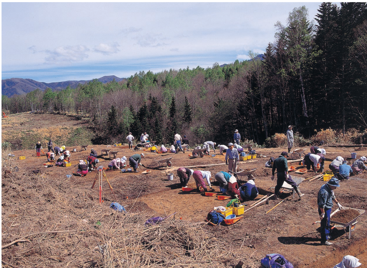
1 平成10年度調査状況(北西から)
