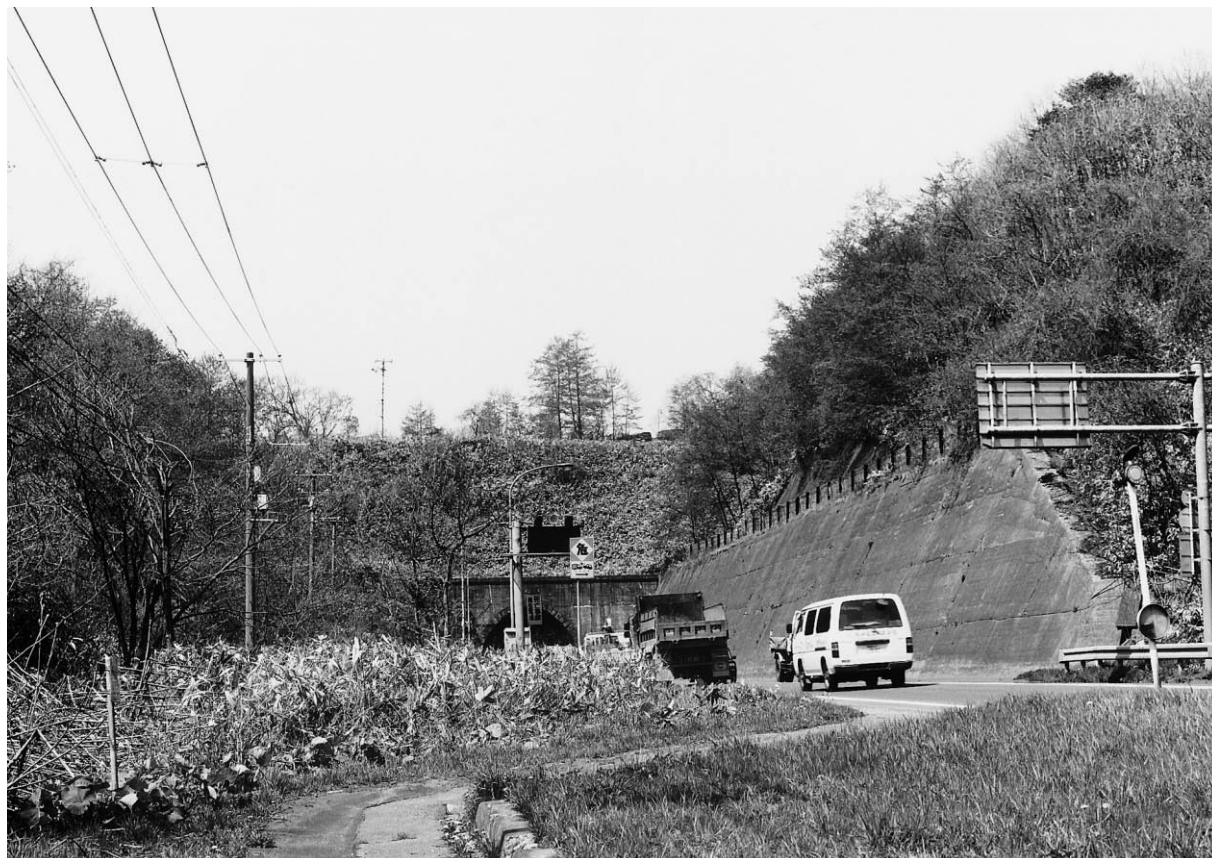
1 遺跡遠景 虎杖浜隧道(北から)
