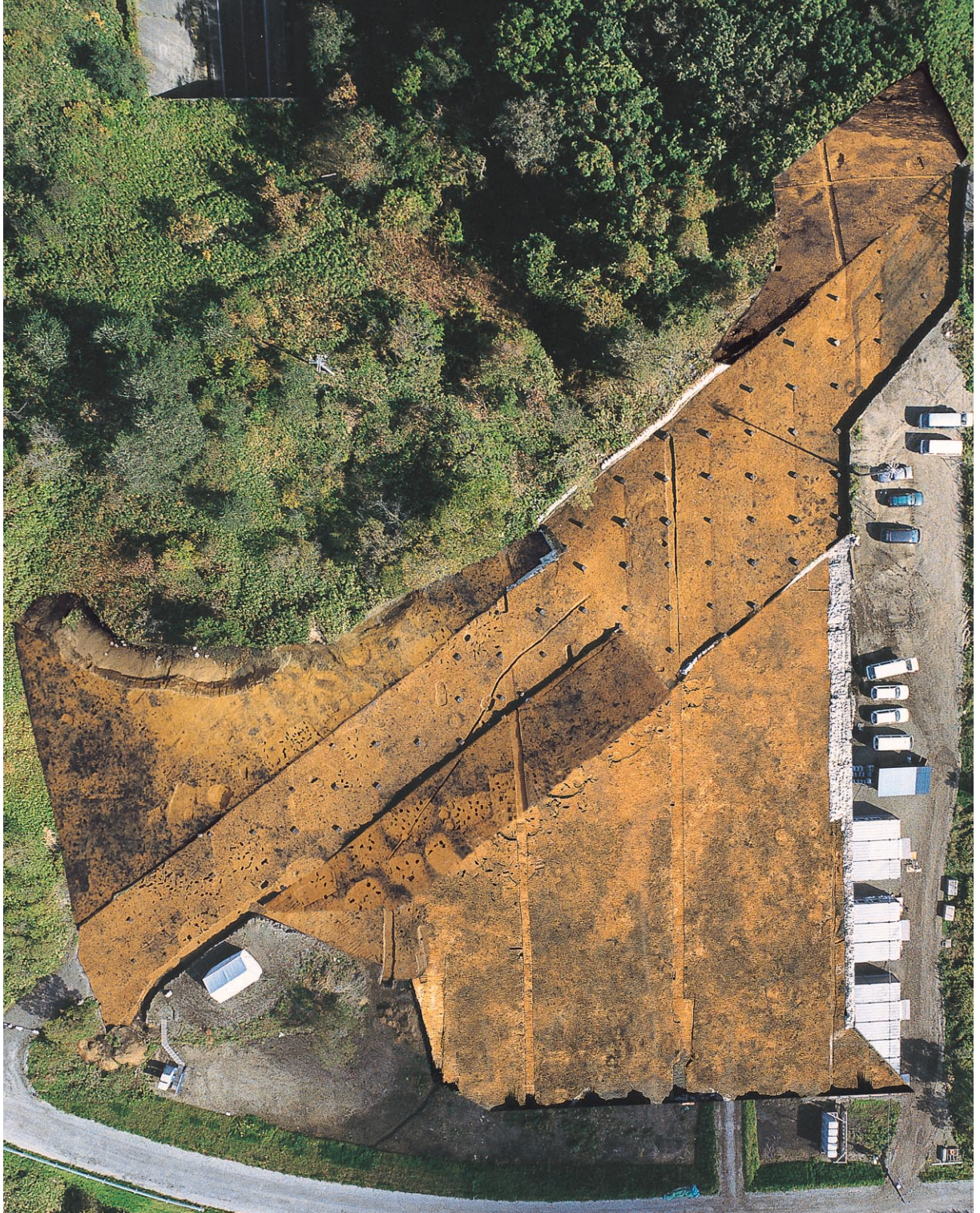
調査区完掘状況(合成写真)
