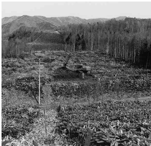
4 平成7年度低位部表土除去(西から)
