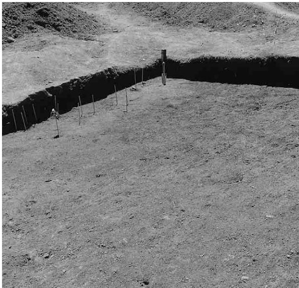
4 Sb-5・20 (M65区、北西から)
