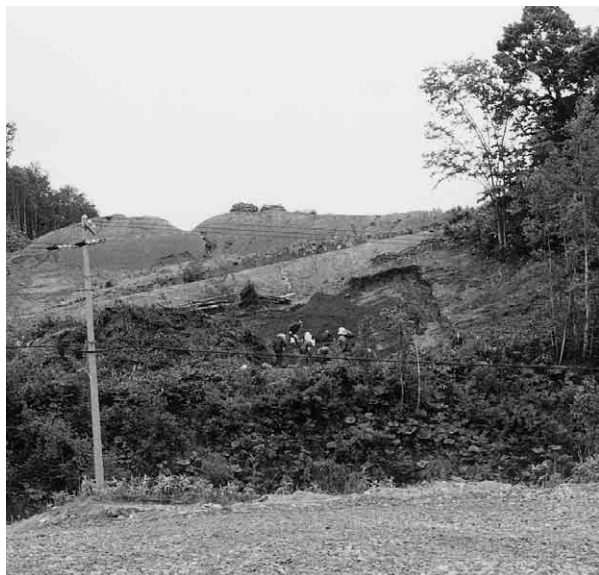
3 平成8年度斜面部調査(東から)
