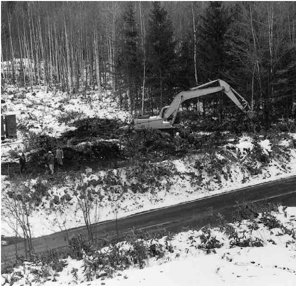
3 平成8年度低位部表土除去(北東から)
