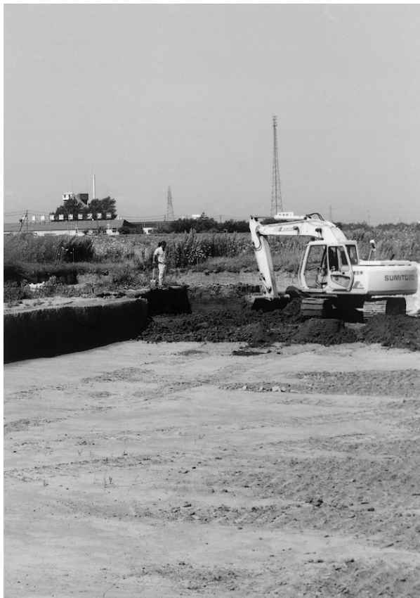
重機による確認調査 E→W
