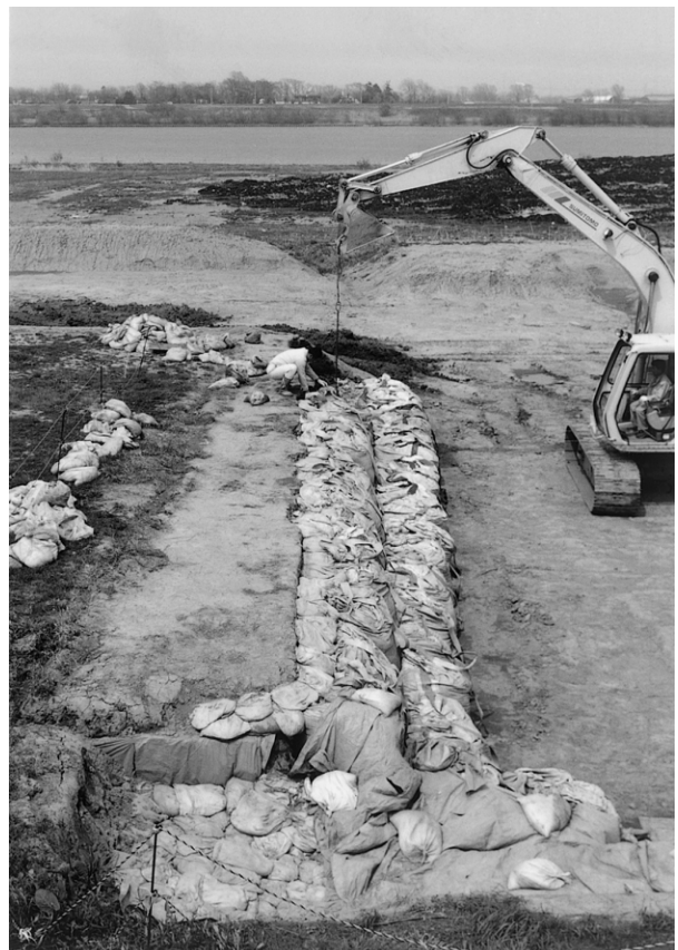
壁面保護用大型土嚢撤去作業 SW→NE
