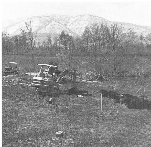
工事立会風景
