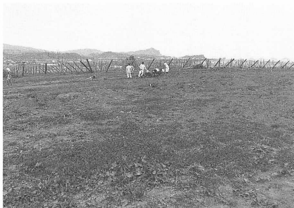
工事立会風景
