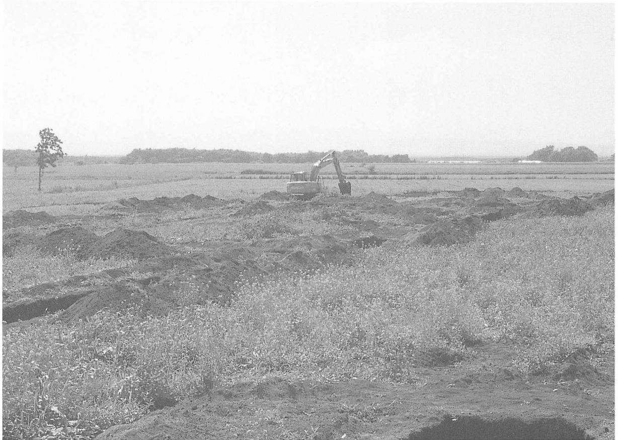
1. 重機作業風景
