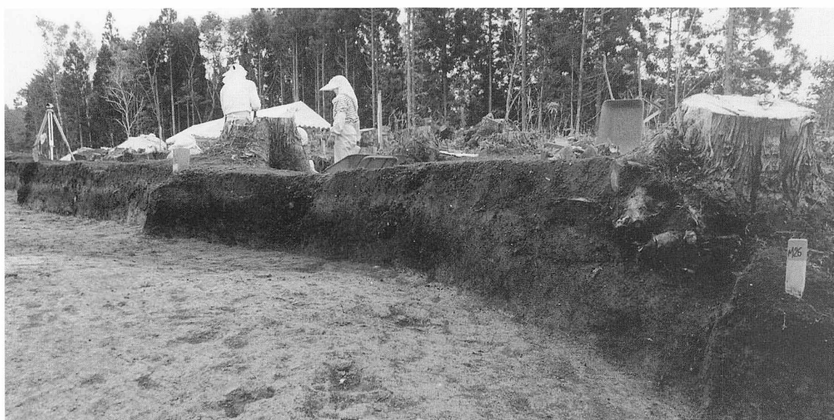
3 メインセクション1 (M-23~26) (北東から)
