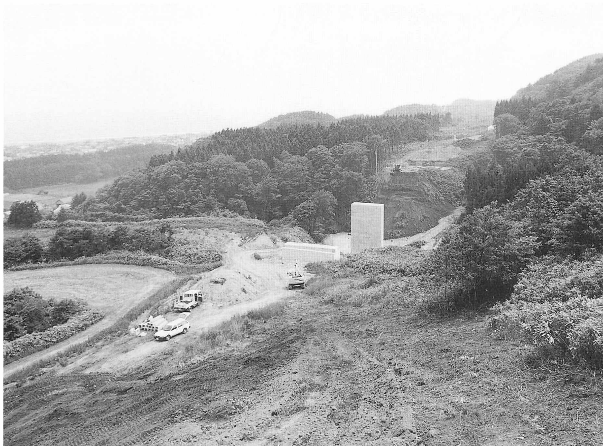
1 遺跡遠景（北西から）
