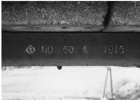
1. 八幡製鐵所1915年1月（2月？）製レール
