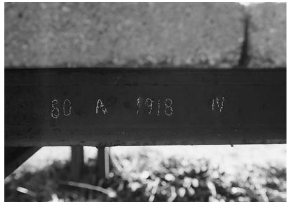
2. 八幡製鐵所1918年3月製レール
