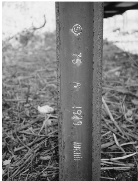
3. 八幡製鐵所1929年10月製レール
