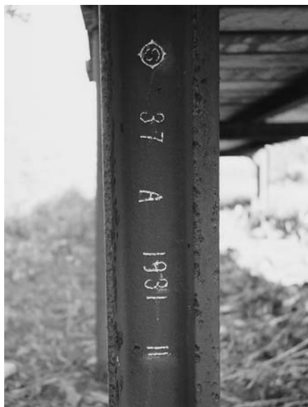
4. 八幡製鐵所1931年2月製レール
