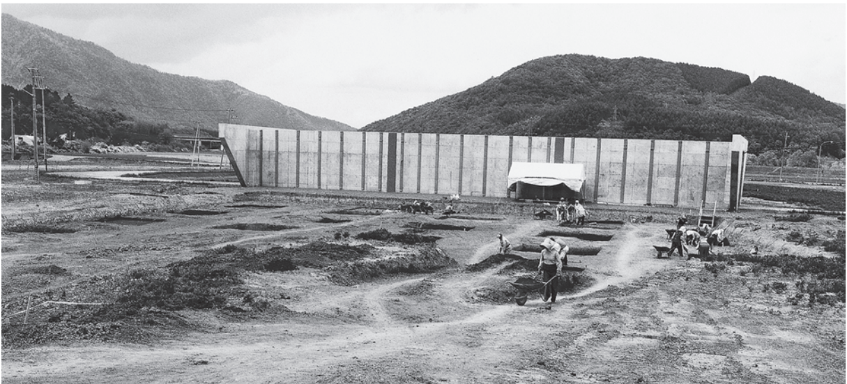
2 調査状況 (南から)
