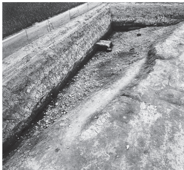
2 北東側セクション (南から)
