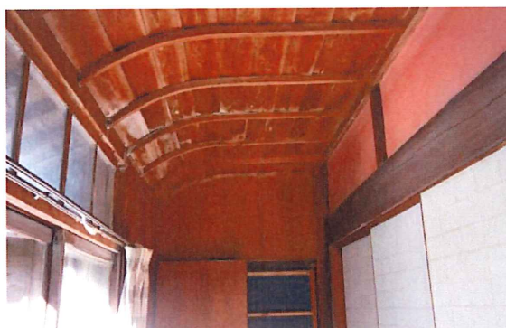
写真 3 玄関横縁側を見上げる
