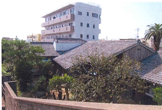
写真 1 遠藤家住宅を南西側からみる
